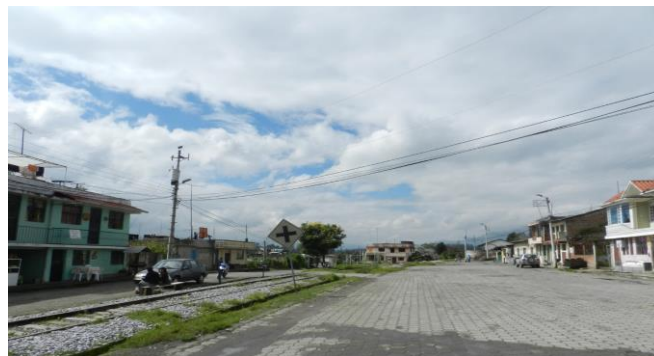
Ilustración 2.7 CRUCE FÉRREA CON VÍA PROVINCIAL Fuente: Empresa Pública de Ferrocarriles del Ecuador
