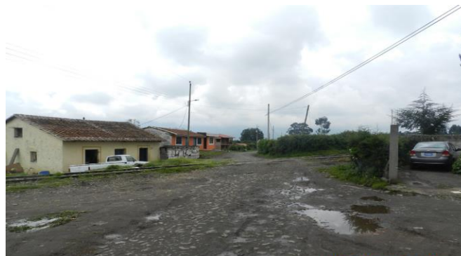
Ilustración 2.8 CRUCE FÉRREA CON VÍA CANTONAL Fuente: Empresa Pública de Ferrocarriles del Ecuador
