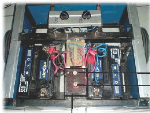
Terminal de carga
