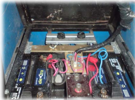
Ilustración 13: Aspecto final de la base inferior en funcionamiento con la conexión entre ambas bases
