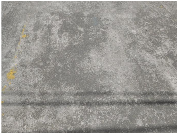
Imagen 7: Superficie de hormigón al interior del centro de manzana. Fuente: Elaboración propia
