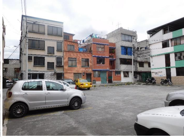
Imagen 6: Altura de edificaciones al interior del centro de manzana. Fuente: Elaboración propia
