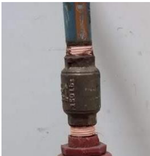
Fotografía 30: Válvula Check
