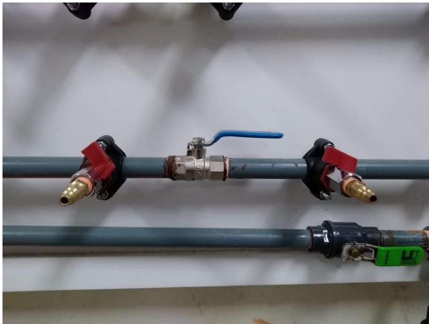
Fotografía 44: Válvula de Bola
