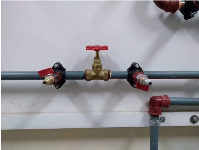
Fotografía 43: Válvula de Globo
