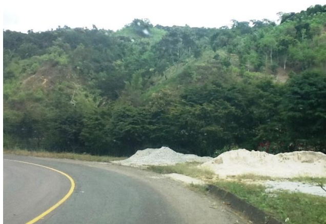
Foto 2: Contaminación por descarga de materiales de construcción – Zona cercana a la entrada de Pacto
