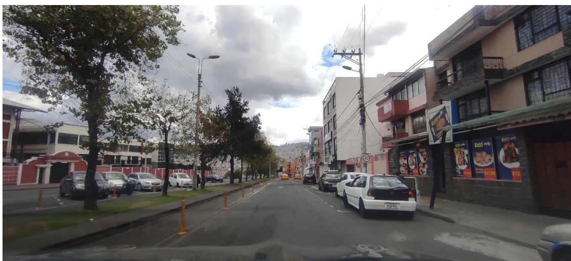
Figura 41 Fotografía alumbrado público - Av. Los Libertadores
