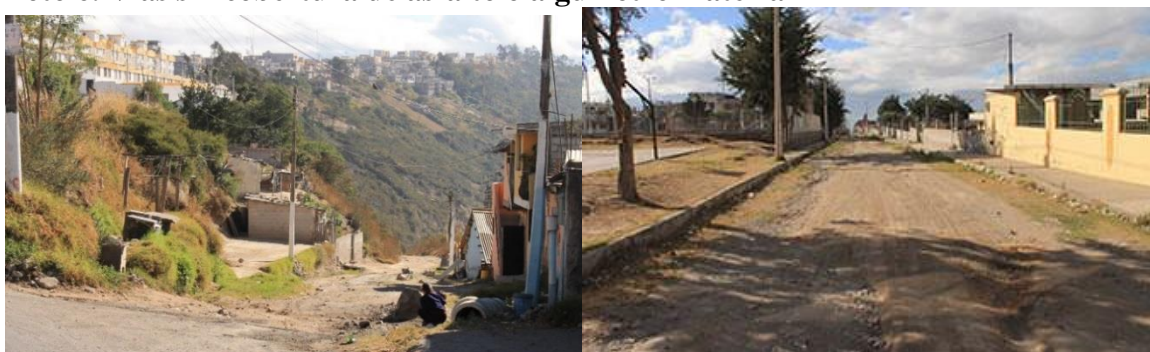
Foto 6. Vías sin cobertura de asfalto o algún otro material
