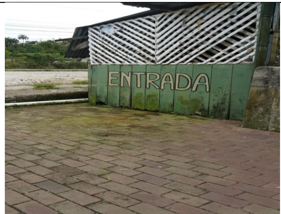
Vivienda de madera en el barrio El Tereré
