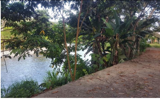
Muro de contención en el barrio Bellavista
