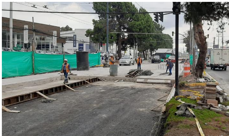
Ilustración 19 Cerramiento de tela de Saran (Autoría Propia)
