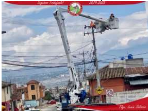
Figura 6. Empresa Eléctrica Ambato atiende un reporte de falla en sistema eléctrico
