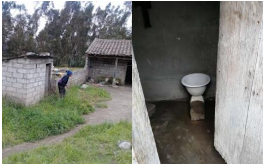
Figura 15. Baño ubicado fuera de los dormitorios atravesando el patio (Fuente: Elaboración propia)
