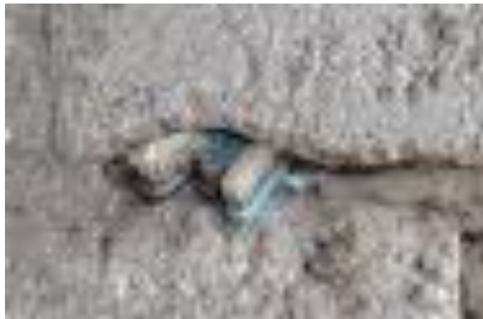
Figura 7. Cepillos dentales incrustados entre los bloques de la pared (Fuente: Elaboración propia)
