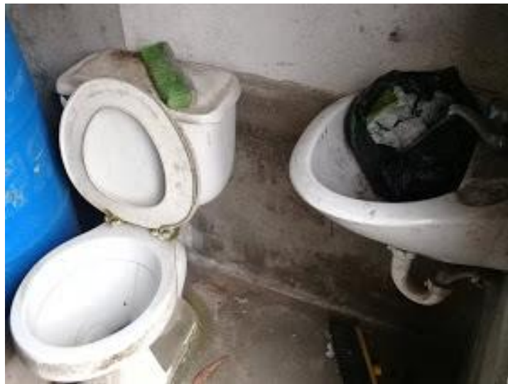
Figura 17. Izq: Baño sin agua sobre pozo séptico. Der: Lavabo de manos sin agua, contiene funda para colocar papel periódico usado (Fuente: Elaboración propia)
