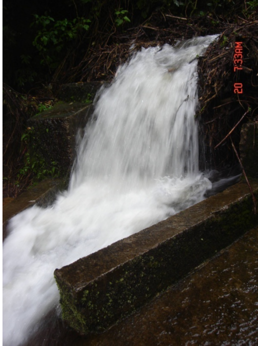
Fotografía 21. Captación del agua superficial a través de una rejilla
