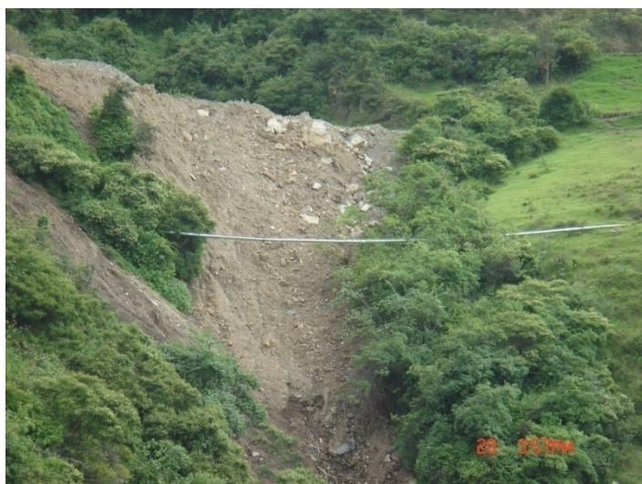
Fotografía 24. Deslizamientos que podrían afectar la red de conducción
