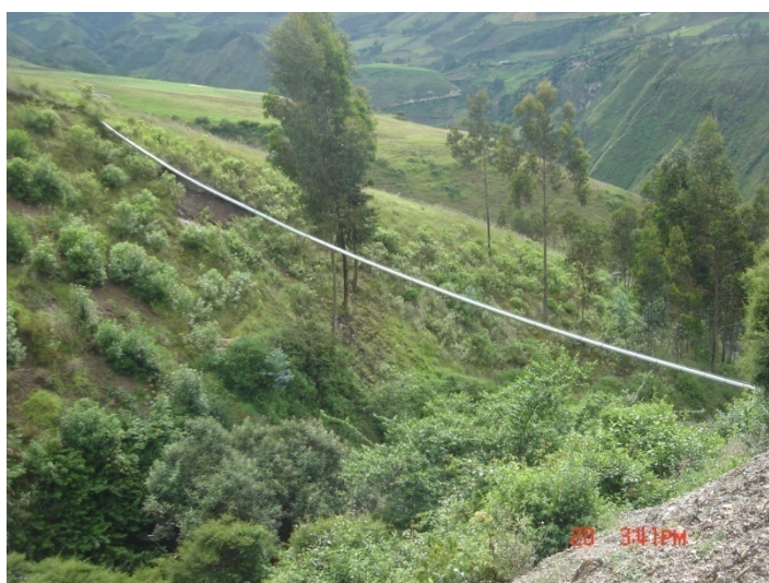
Fotografía 25. Largos tramos de tubería sin pilares que la sostengan
