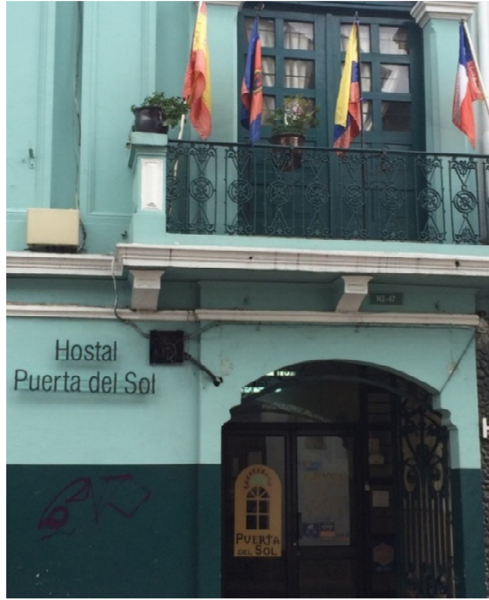
Foto N° 6: Hostal Puertas del Sol
