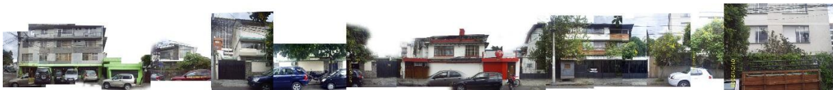
Fachada calle Jaura (oeste)
