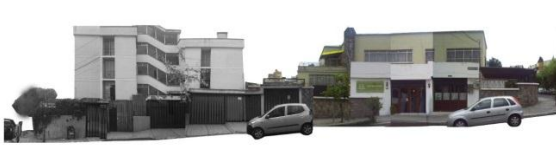
Fachada calle García (norte)
