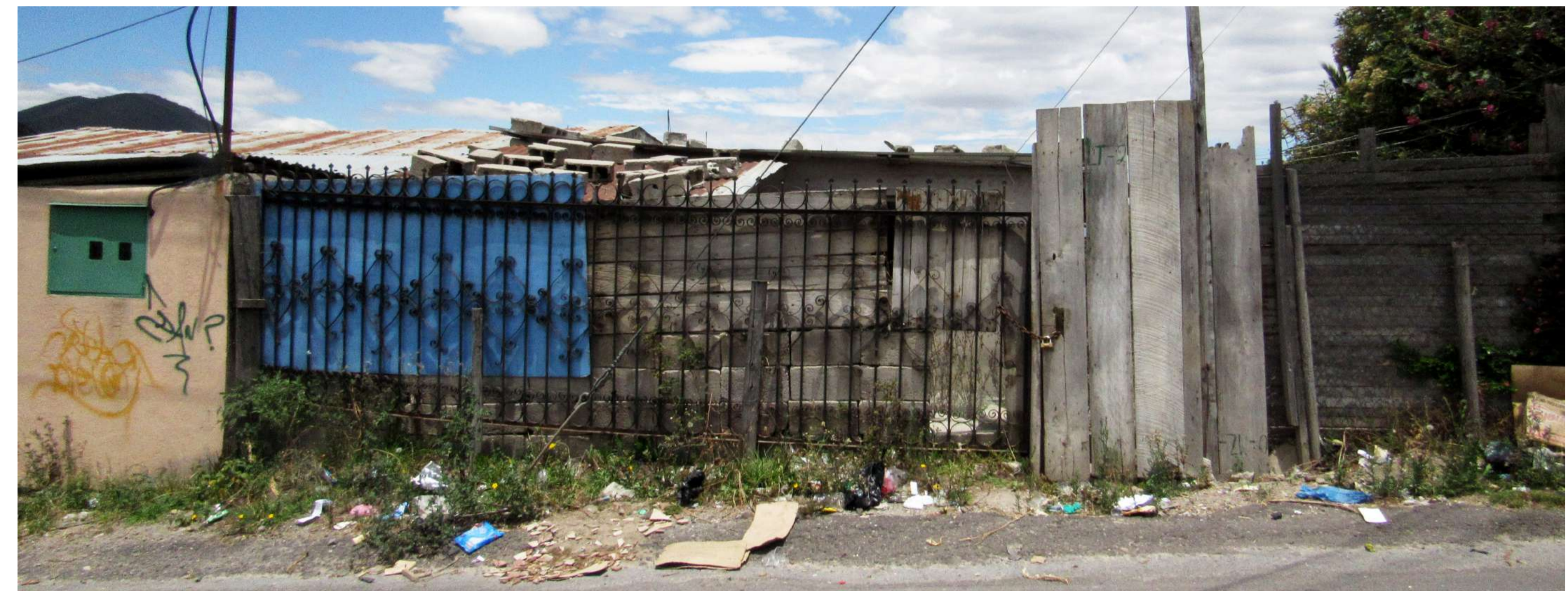
2 Lotes vacíos o abandonados en mal estado
