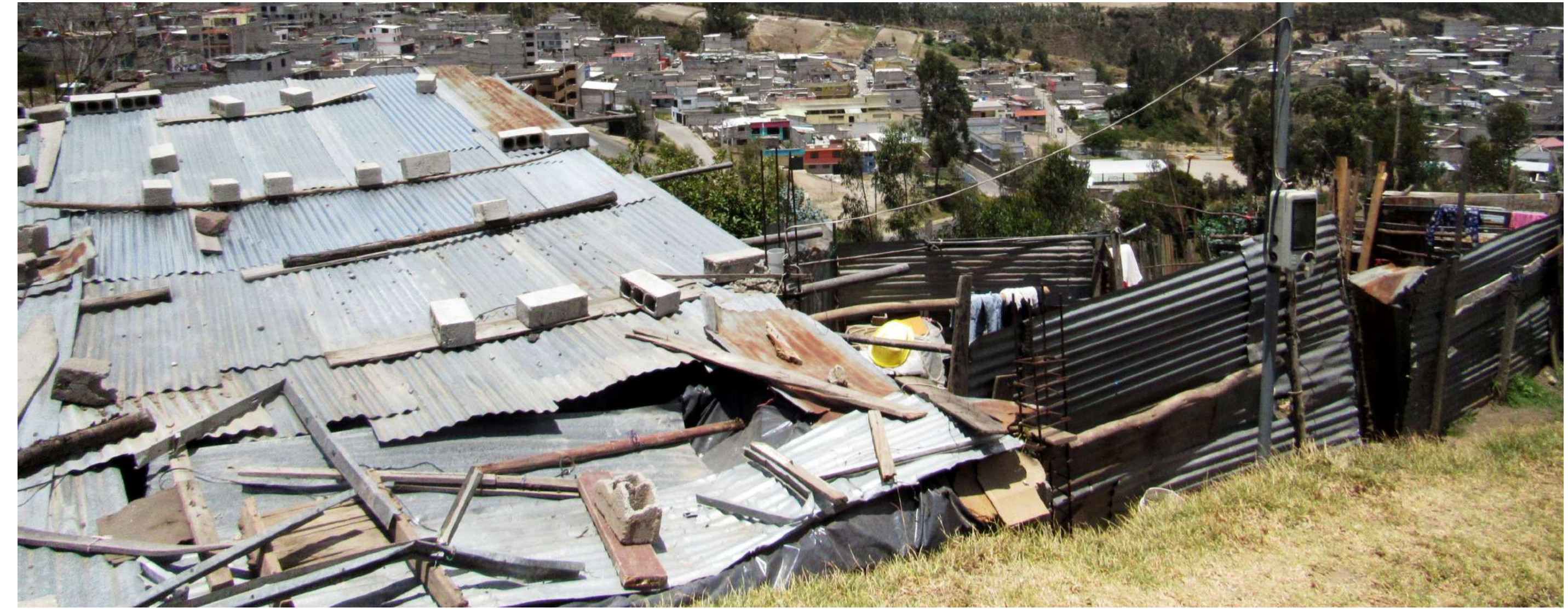
1 Viviendas Precarias cerca a la Quebrada Carnicería
