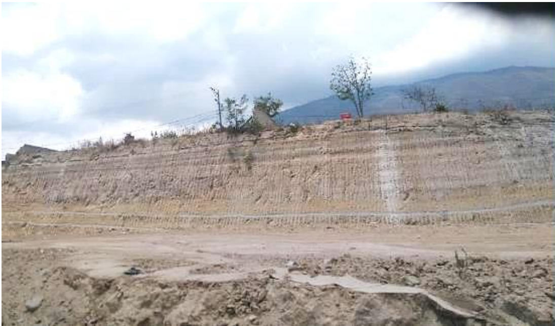
Fotografía 5.- Excavación en ampliación de Av. Simón Bolívar, al norte de ciudad Bicentenario
