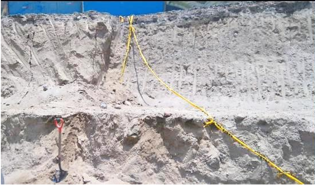
Fotografía 4.- Excavación en ampliación de Av. Simón Bolívar, cercana al punto EX2
