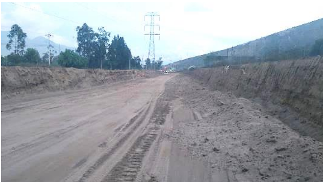
Fotografía 3.- Excavación en ampliación de Av. Simón Bolívar, cercana al punto EX1
