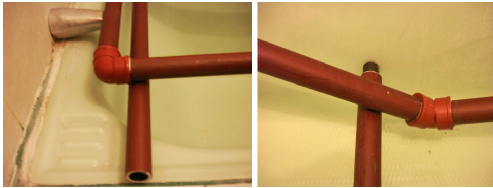
(Img. 22) Verificación de medidas exteriores
