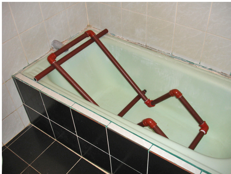
(Img. 21) Verificación de medidas interiores
