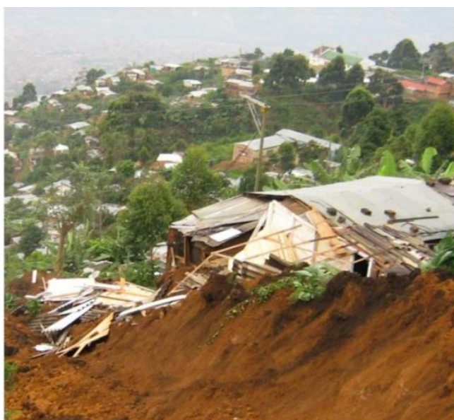
Figura 32: Afectaciones por deslizamiento en las laderas de Medellín
