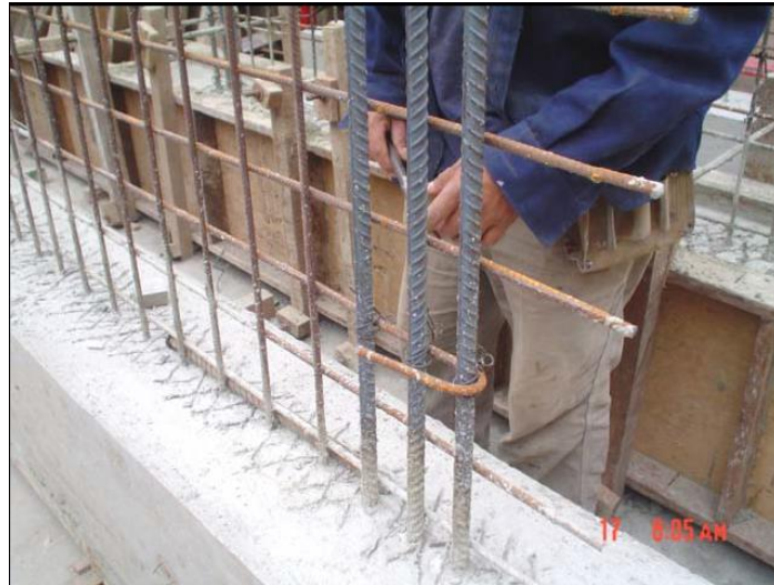
Figura 1-21 Armado de muros
