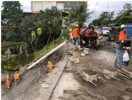
Hormigón lanzado en talud irregular
