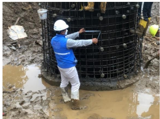
Control del armado en pozo
