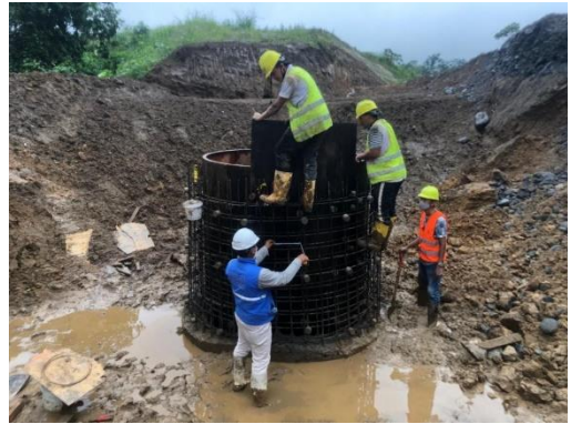
Control del armado en pozos
