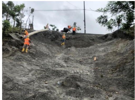
Hormigón lanzado en talud irregular
