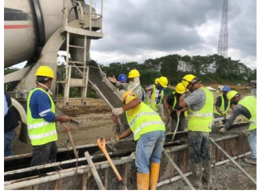
Fundición con hormigón premezclado en bordillo
