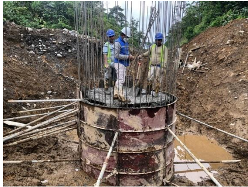
Control del armado en pozos
