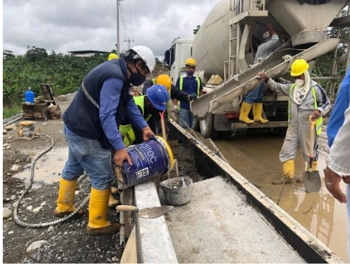
Fundición con hormigón premezclado en bordillo
