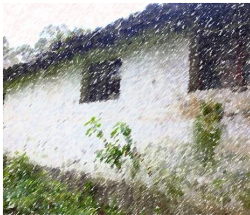
Fotografía 1 y Fotografía 2: Paredes de Tapial del Caso de estudio
