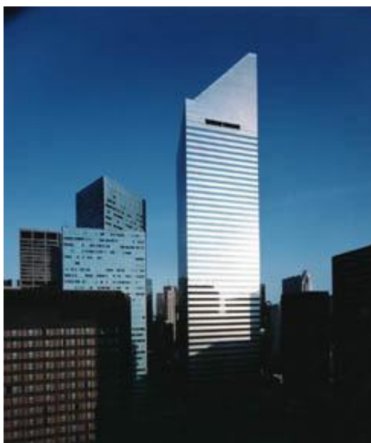
ILUSTRACIÓN 5: EDIFICIO CITIGROUP CENTER
