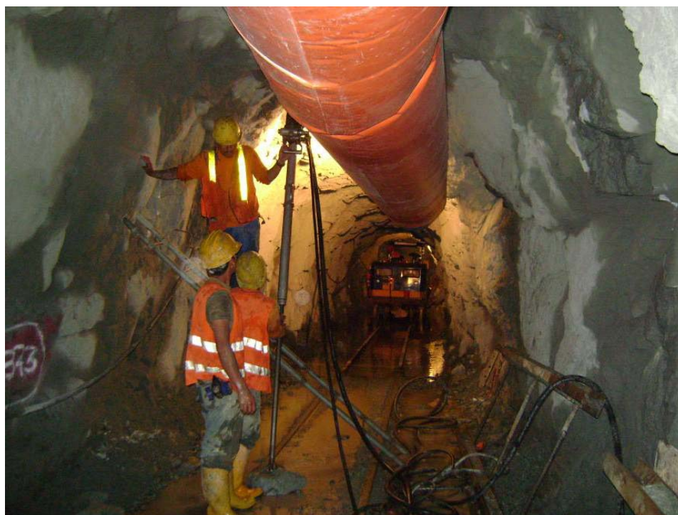
Figura No. 140 Trabajos en el túnel. INTERNET. 2010. 191
