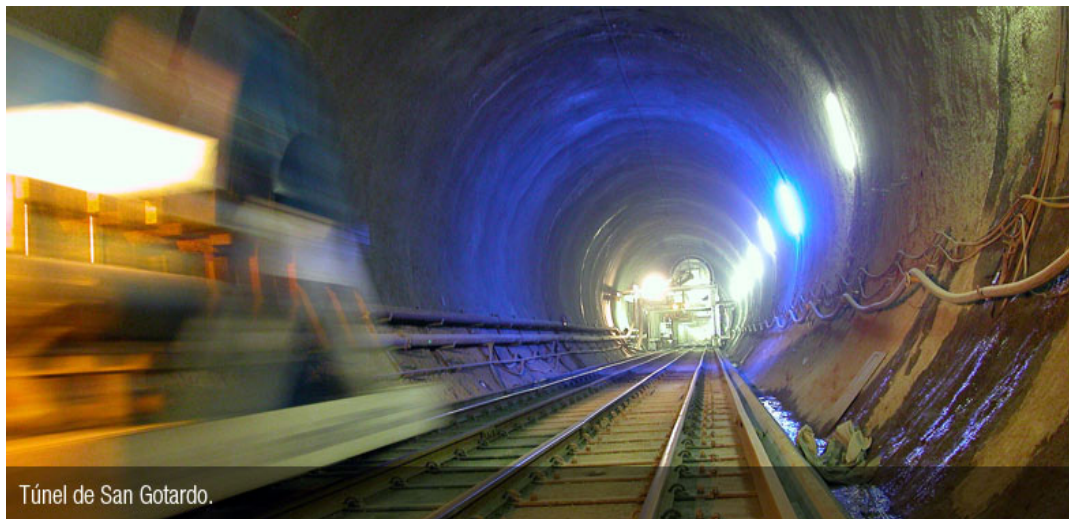
Figura No. 14 Túnel de San Gotardo. (AIME & GEOCONSULT, 2006). 26
