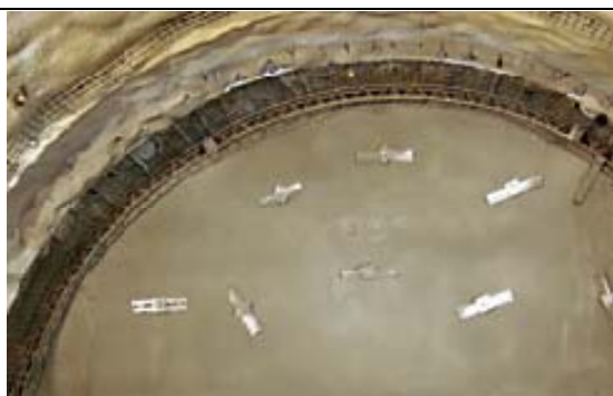
Figura No. 106 Entibación rígida de un túnel circular para conducción de aguas, con sección H. (LOPEZ JIMENO, 2000) 159
