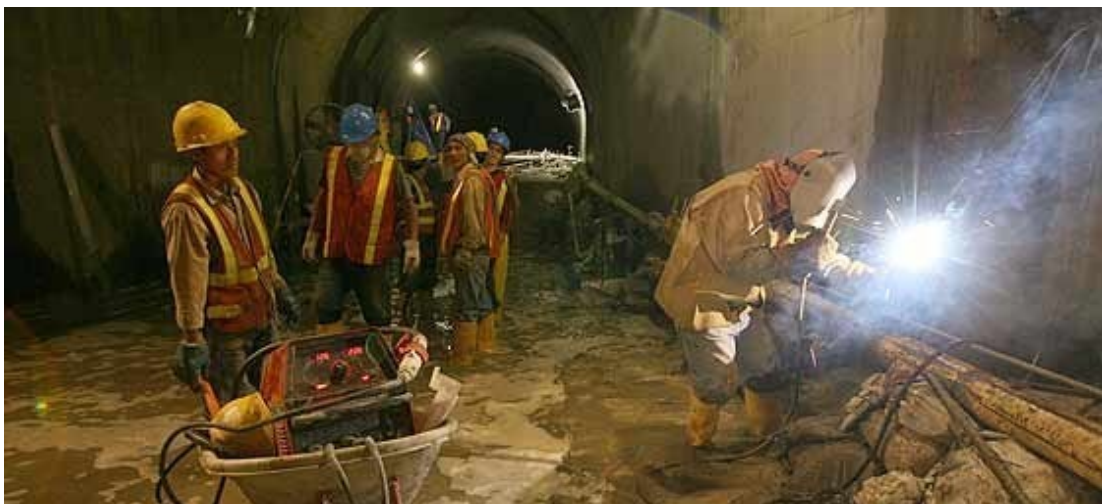
Figura No. 131 Reparación de hastiales en túnel San Francisco. INTERNET, 2010. 184
