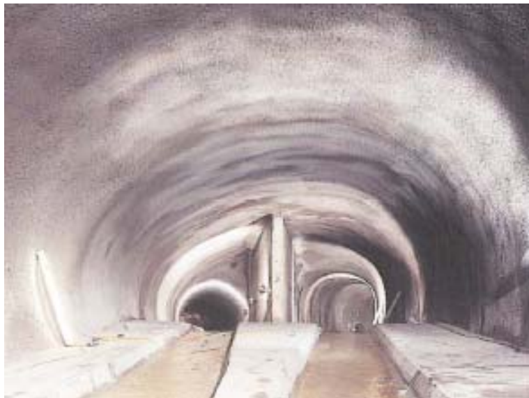
Figura No. 27 Túnel Hidráulico de alcantarillado, Kriens - Suiza. (AIME & GEOCONSULT, 2006) 45
