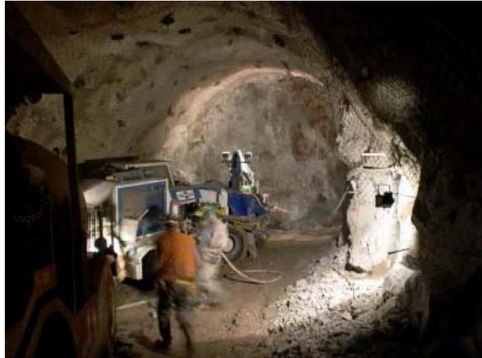
Figura No. 116 Uso Clásico de hormigón lanzado. Revestimiento primario. (AIME & GEOCONSULT, 2006) 167
