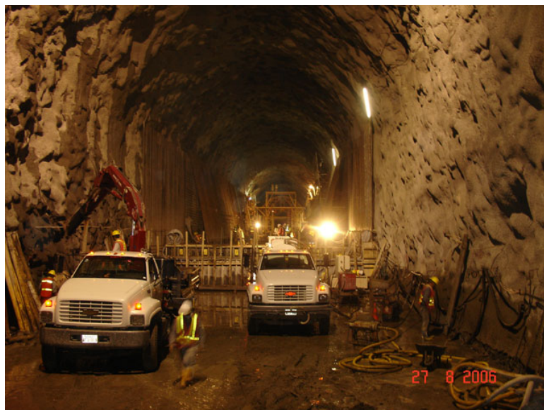
Figura No. 146 Sostenimiento con anclajes y hormigón lanzado. – Armado de marcos rígidos para el revestimiento final en la parte posterior de la imagen. MAZAR. INTERNET 2010. 197
