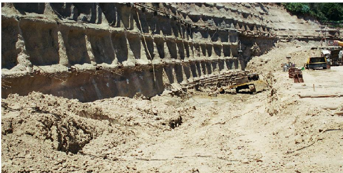
Figura No. 136 Obras adicionales para estabilizar taludes. (PROAÑO, 2009) 188
