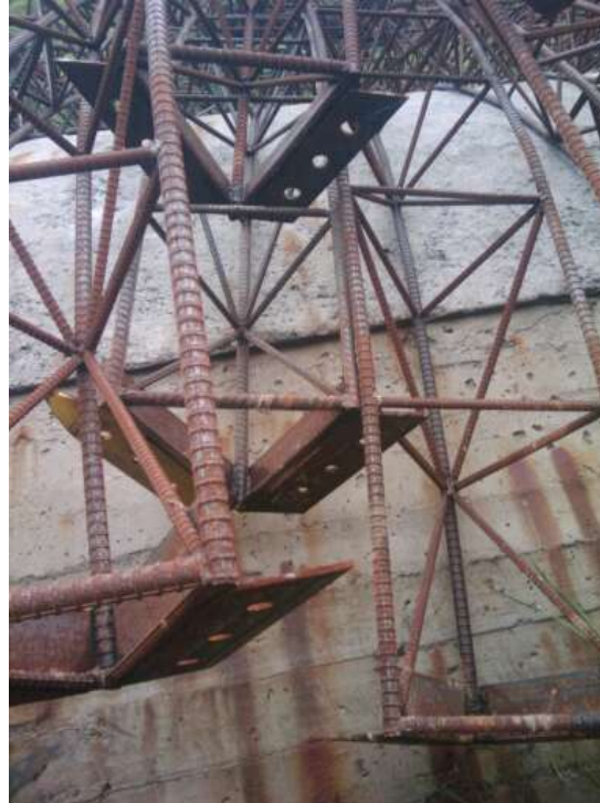
Figura No. 129 Cerchas utilizadas para crear marcos de sostenimiento. Imagen tomada el 10 de marzo de 2010.
