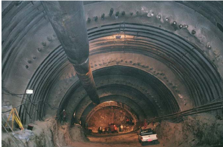
Figura No. 20 Construcción Túnel Guayasamín. INTERNET. 2010. 33
