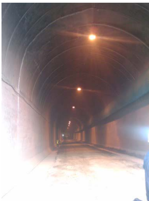
Figura No. 121 Túnel de conducción a gravedad Intercambiador El Trébol. Fotografía tomada el 10 de marzo de 2010.
