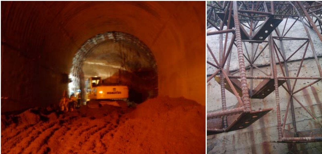
Figura No. 109 Celosía en el túnel de conducción a gravedad bajo el Intercambiador El Trébol. Fotografía tomada el 10 de marzo de 2010.
