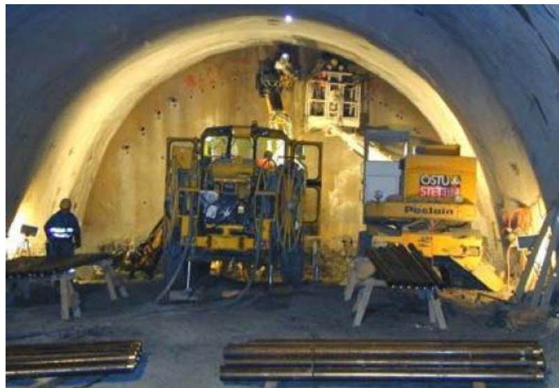
Figura No. 66 Inyecciones de Consolidación. (AIME & GEOCONSULT, 2006) 114
