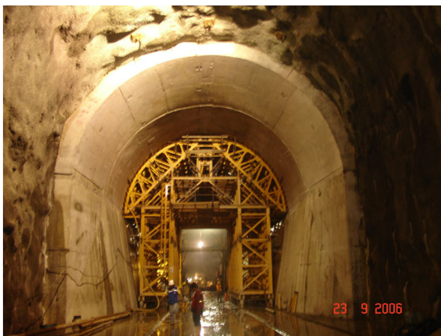
Figura No. 148 Sostenimiento mediante anclajes en la parte delantera de la imagen. Sección de túnel final construida en la parte trasera de la imagen. INTERNET 2010. 198
