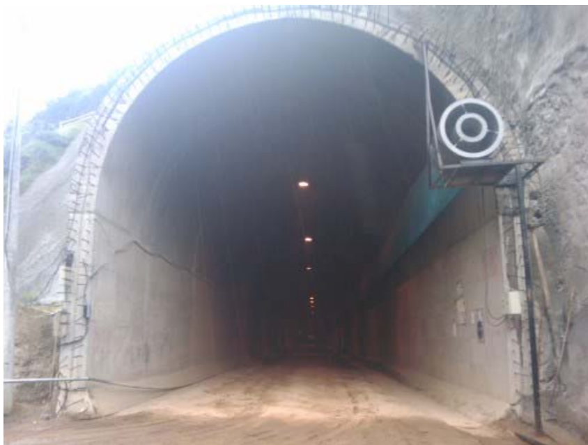
Figura No. 127 Túnel colector nuevo, bajo el intercambiador El Trébol. Imagen tomada el 10 de marzo de 2010.
