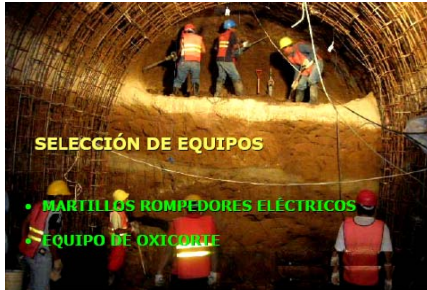
Figura No. 87 Equipo de excavación para túneles mayores a 5m. (AIME & GEOCONSULT, 2006) 134
