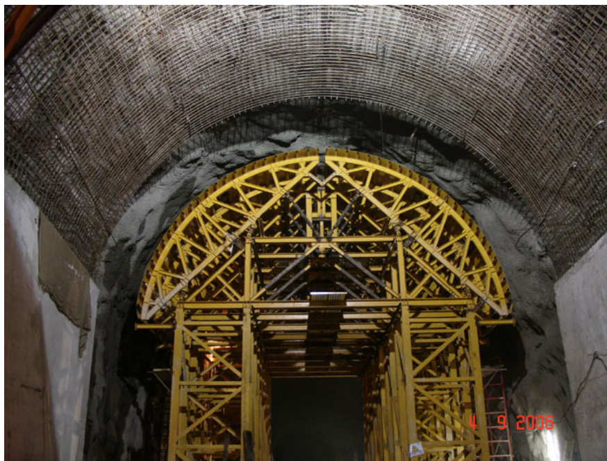
Figura No. 147 Sistema de encofrado del túnel. MAZAR. INTERNET 2010. 198
