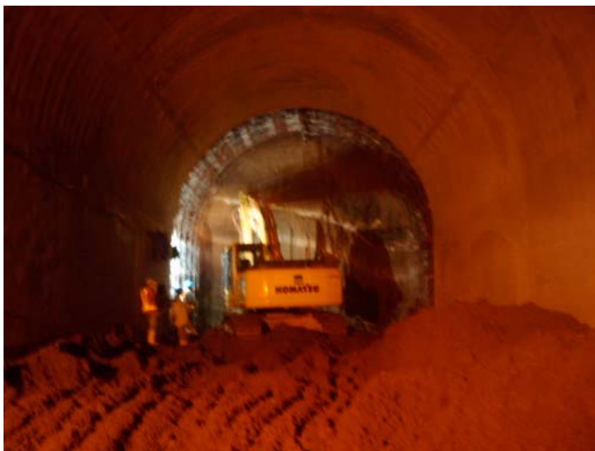
Figura No. 128 Ejecución de la Destroza del Túnel. Método Belga de Excavación. Imagen tomada el 10 de marzo de 2010.
