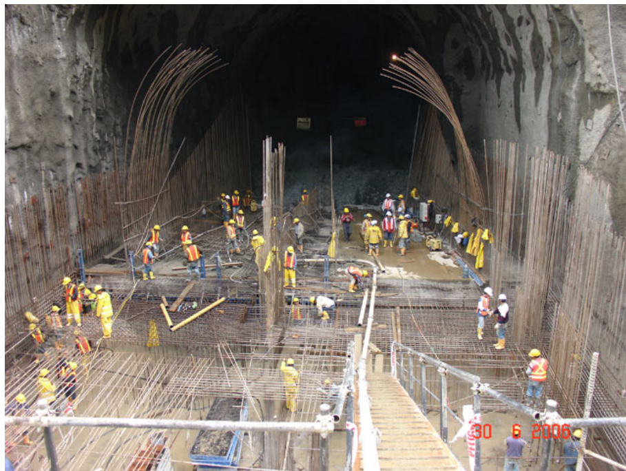
Figura No. 144 Armado de túnel – Portal de Entrada del túnel de desvío. MAZAR. INTERNET 2010. 195
