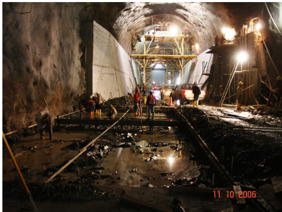
Figura No. 149 Construcción del revestimiento del túnel. Sostenimiento previo con pernos de anclaje y hormigón lanzado. MAZAR. INTERNET 2010. 199
