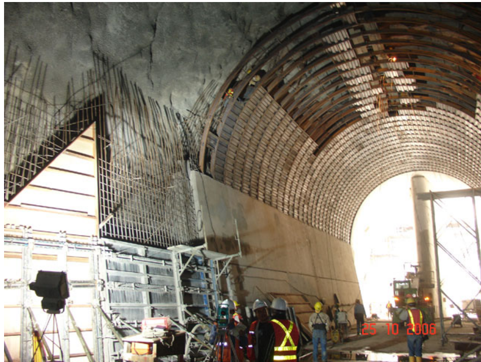
Figura No. 21 Túnel de Desvío Represa Mazar INTERNET. 2010. 34
