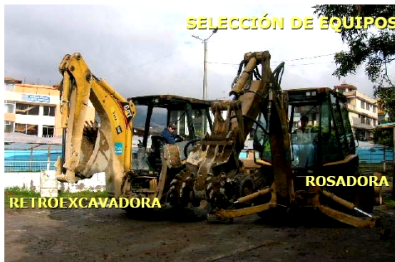
Figura No. 86 Equipo de excavación para túneles mayores a 5m. (AIME & GEOCONSULT, 2006) 133
