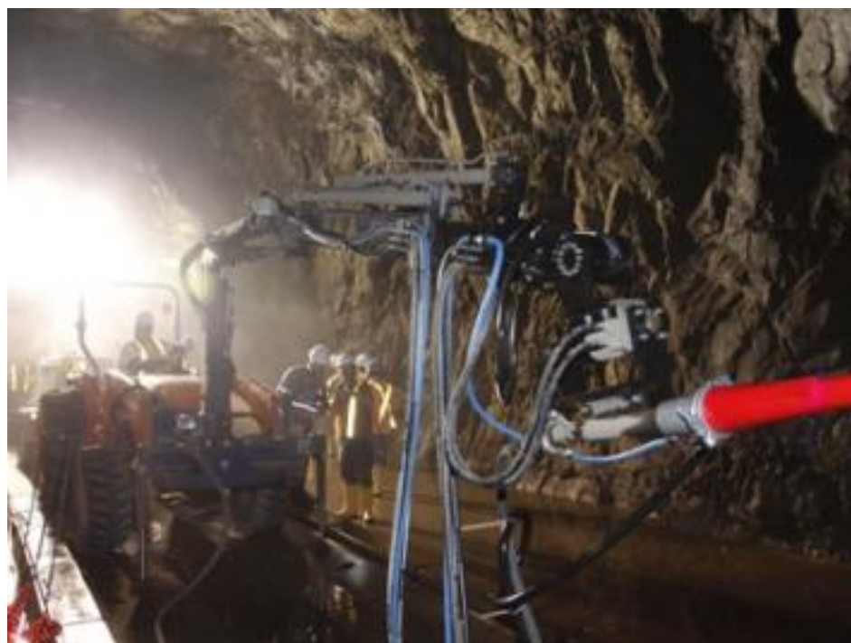
Figura No. 132 Reparaciones de túnel de conducción San Francisco. INTERNET, 2010. 185
