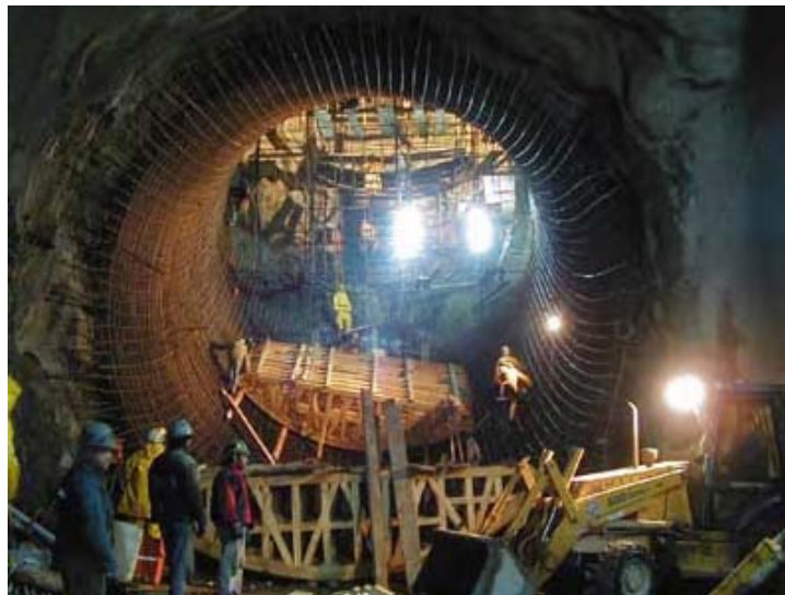
Figura No. 124 Revestimiento con Hormigón Autocompactante.(AIME & GEOCONSULT, 2006) 177
