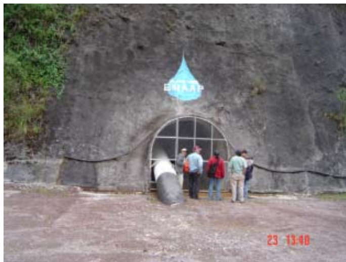
Figura No. 43 Emboquillaje del Túnel, lugar donde obligatoriamente se deberá realizar por lo menos un sondeo mecánico. (AIME & GEOCONSULT, 2006). 74
