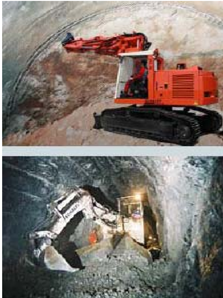
Figura No. 75 Construcción Mecanizada de túneles. (AIME & GEOCONSULT, 2006) 126
