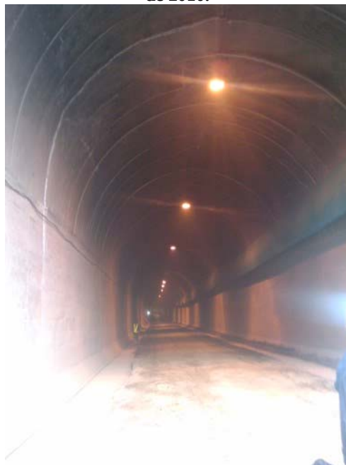
Figura No. 130 Acabado del túnel. Frente de excavación inicial. Imagen tomada el 10 de marzo de 2010.
