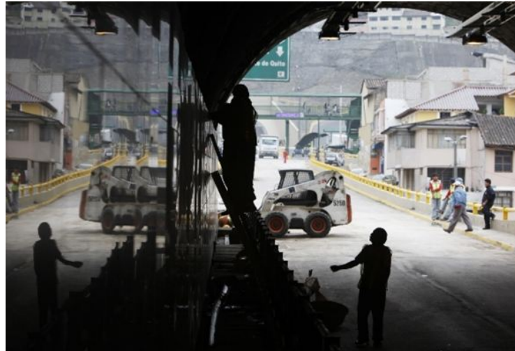
Figura No. 19 Túnel de San Diego-Quito. Colocación de pavimento Rígido. INTERNET. 32 2010.
