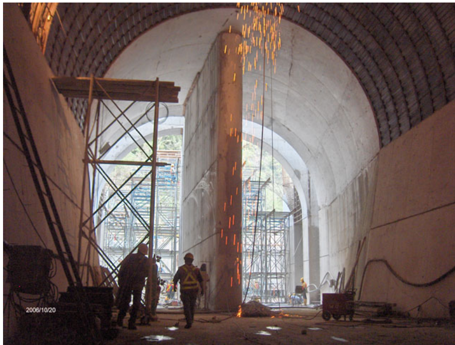
Figura No. 145 Armado de revestimiento de túnel – Portal de Entrada del túnel de desvío. MAZAR. INTERNET 2010. 196
