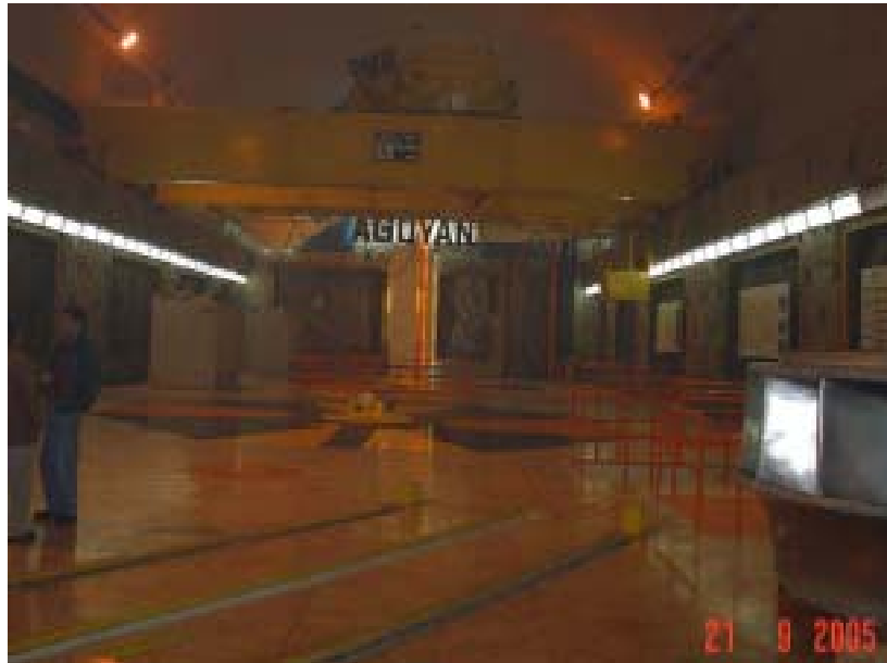
Figura No. 28 Casa de Máquinas, Agoyán – Hidropastaza - Ecuador. (AIME & GEOCONSULT, 2006). 46
