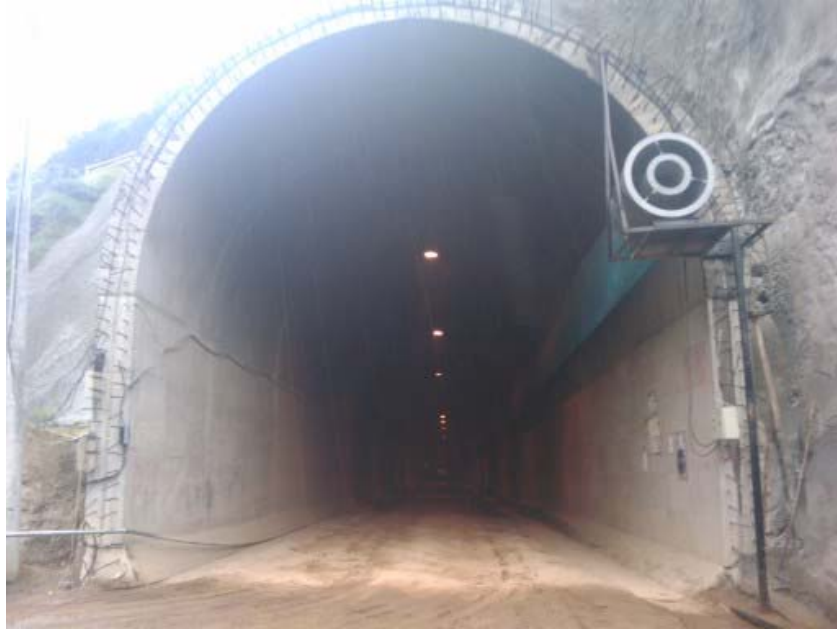
Figura No. 100 Armado del túnel de conducción a gravedad bajo el Intercambiador El Trébol. Fotografía tomada el 10 de marzo de 2010.
