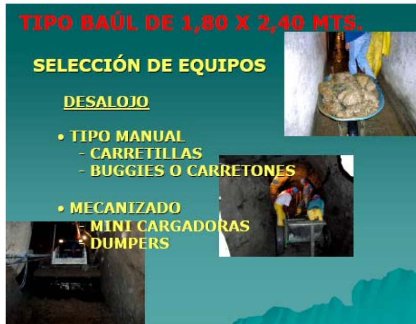
Figura No. 83 Tipo Baúl 1.80m. x 2.40m. Desalojo de materiales. (AIME & GEOCONSULT, 2006) 132
