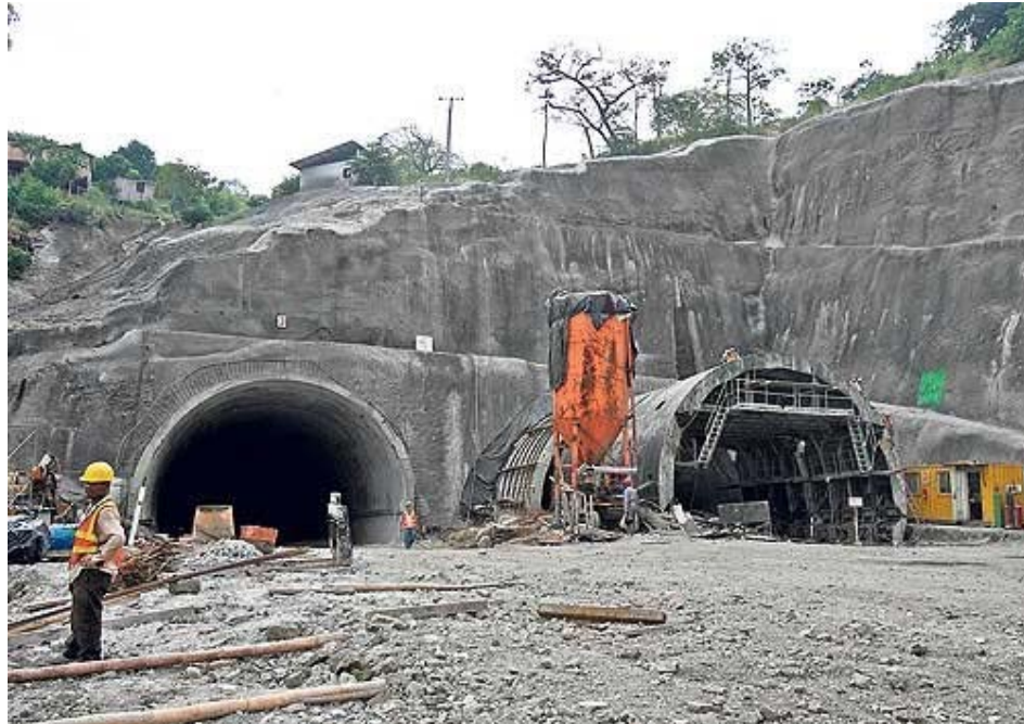
Figura No. 23 Túneles San Eduardo. INTERNET. 2010. 36
