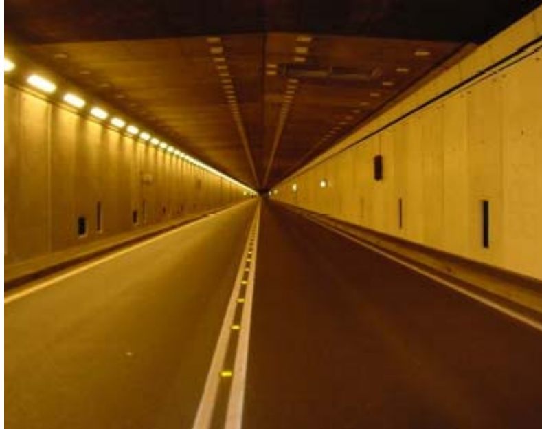
Figura No. 26 Túnel de San Gotardo. (AIME & GEOCONSULT, 2006) 45
