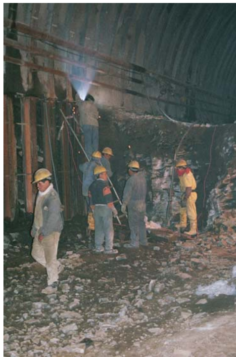
Figura No. 101 Sostenimiento con vigas tipo H, túnel vial Guayasamín. (PROAÑO, 2009) 153
