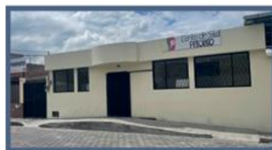
SUBCENTRO DE SALUD PRIORATO
