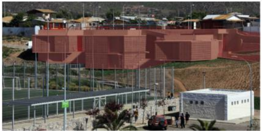
Nota: Adaptado de ArchDaily, por 3 Arquitectos, 2011, ( https://www.archdaily.cl/cl/sY1FB8Cfz4/sede-social-comunitaria-3-arquitectos ).
