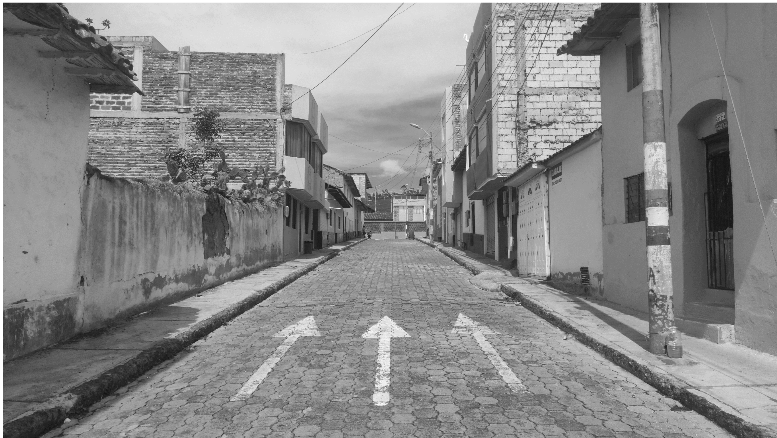
Figura 191: Estado actual calle Abadón Calderón. Fuente: Elaboración propia.
