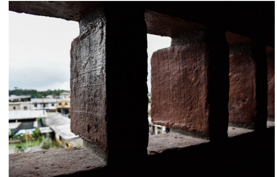
Figura 118: Vista a detalle del aparejo de ladrillos utilizado. Fuente: Arch daily.
