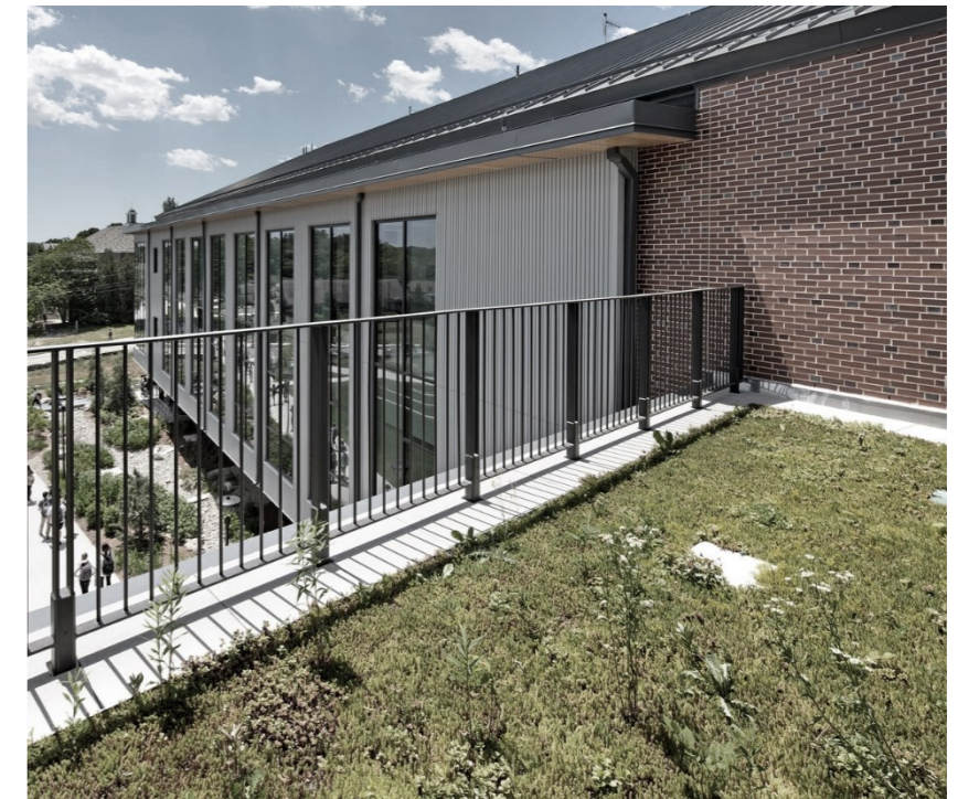
Figura 79: Vista exterior de cubiertas verdes. Fuente: Archtizer.
