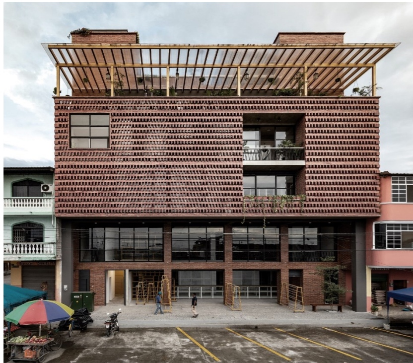
Figura 122: Vista frontal Centro Productivo La Proveedora. Fuente: Arch daily.
