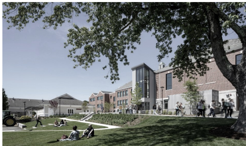
Figura 70: Vista interior y exterior del bloque Gilbert Hall. Fuente: Archtizzer.
