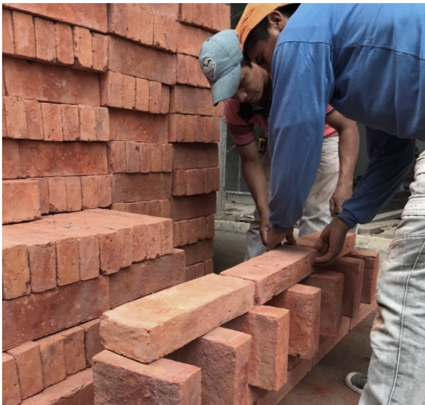
Figura 123: Aparejo previo del ladrillo para la fachada frontal. Fuente: Arch daily.
