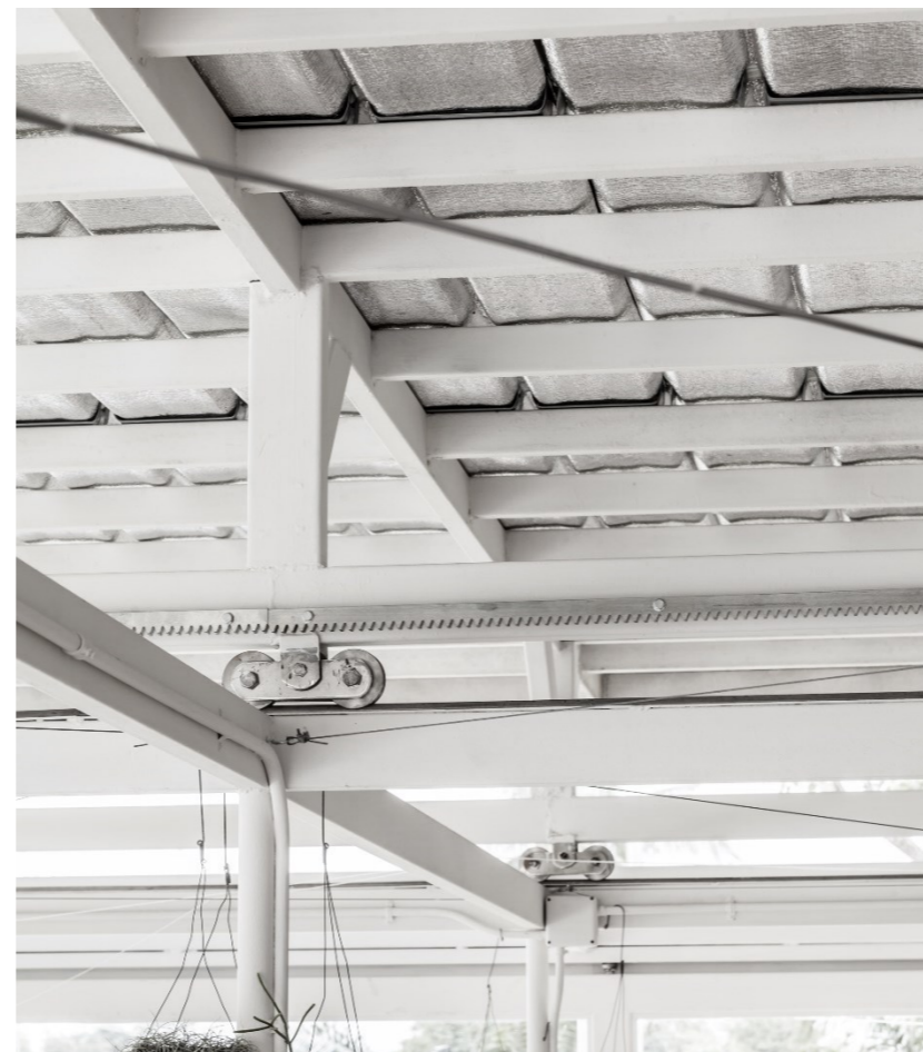
Figura 86: Vista interna de la cubierta móvil. Fuente: Archdaily.
