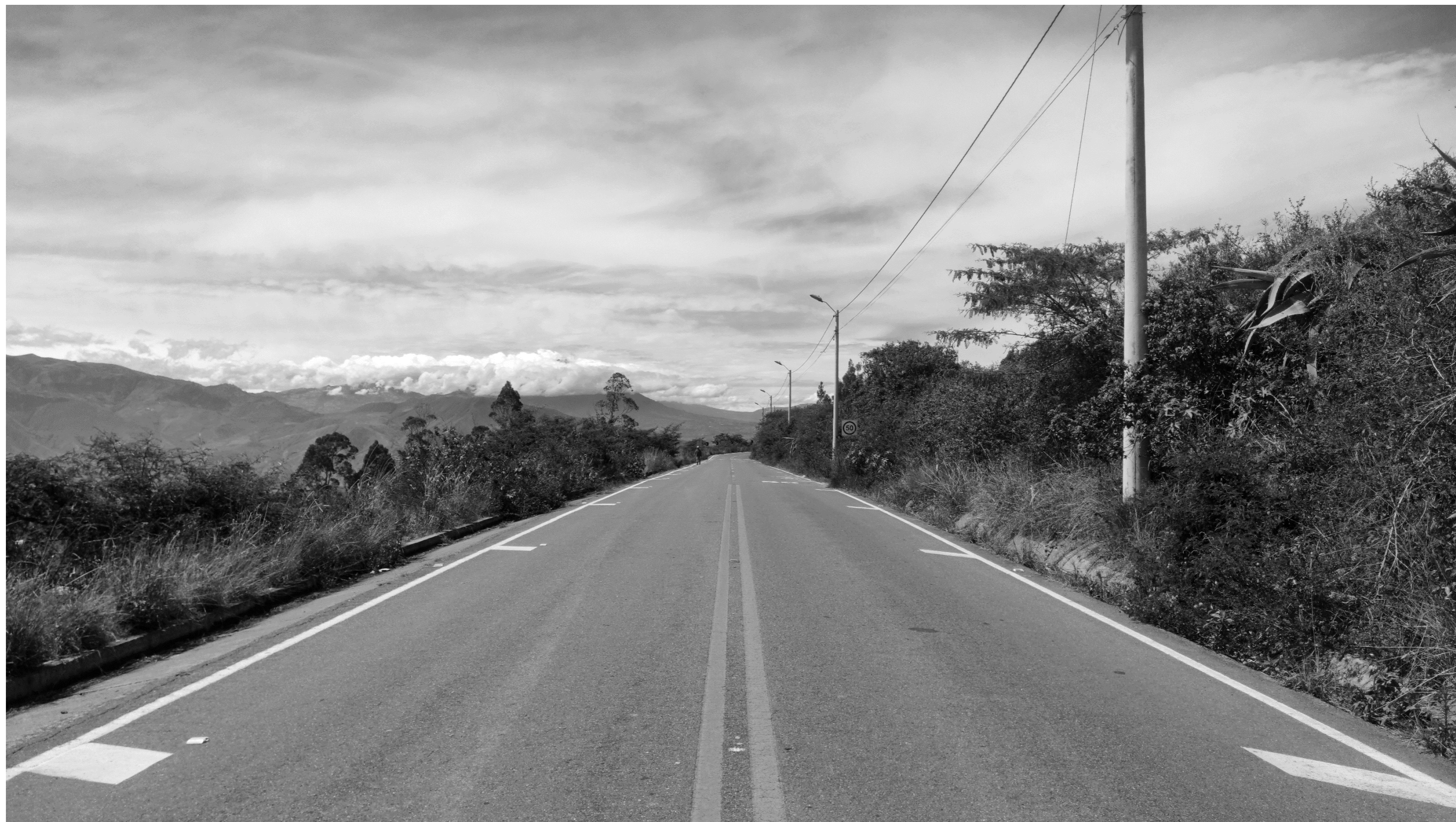
Figura 197: Estado actual vía Mira Estación Cárcchi. Fuente: Elaboración propia.
