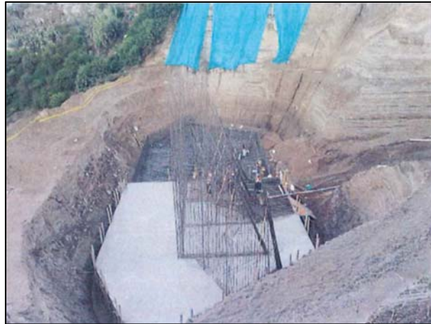
Figura 20: Foto referencia construcción de zapata.
