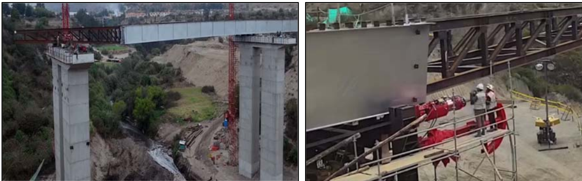
Figura 24: Foto referencia lanzamiento de viga.
