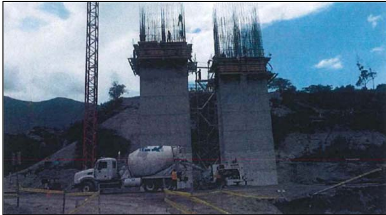
Figura 21: Foto referencia construcción de pila.
