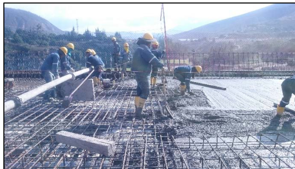
Figura 26: Foto referencia fundación de la losa.
