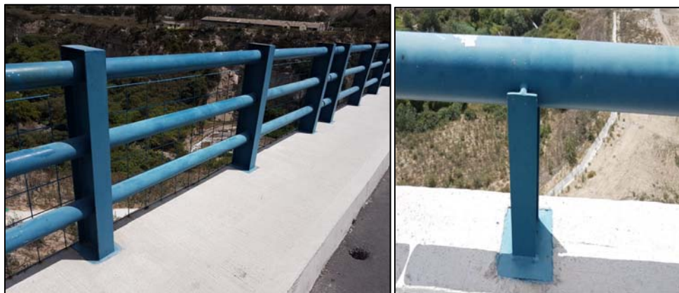
Figura 27: Foto referencia barandas metálicas.
