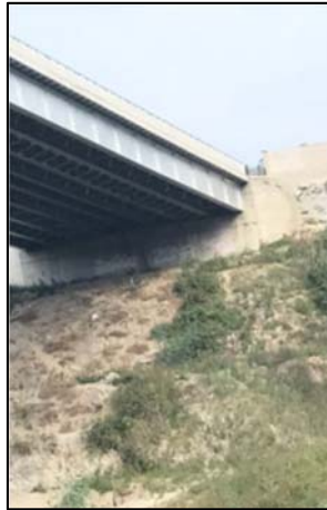
Figura 22: Foto referencia construcción de estribos.
