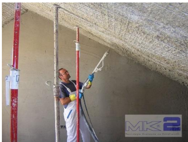
FOTO 2. LANZAMIENTO DE HORMIGON EN TUMBADOS FUENTE: PAGINA WEB MK2
