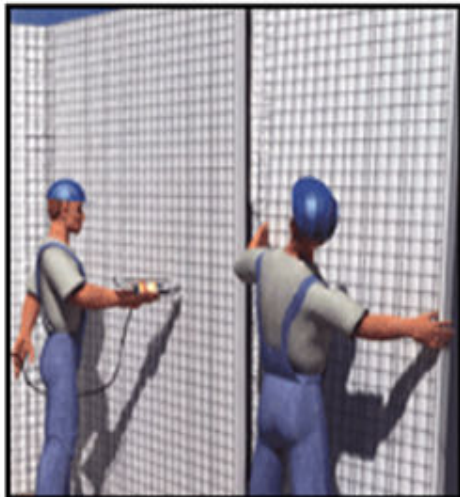
(a) Colocación del panel para pared.
