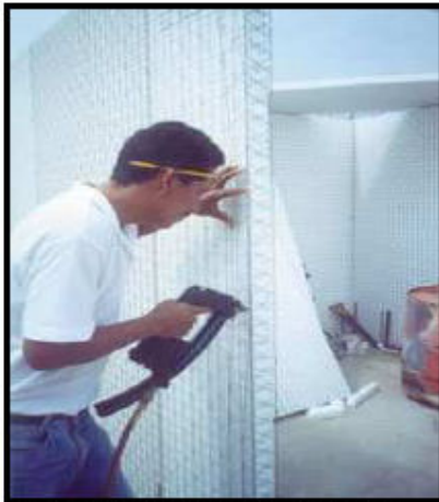
Figura 2.5. Instalación del panel.
