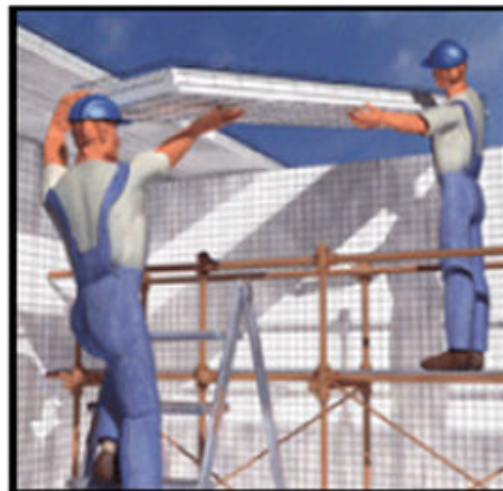
(b) Colocación del panel para entrepiso.
