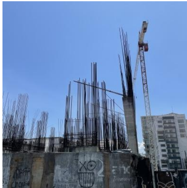
Figura 17 Deterioro del muro que delimita el lote, Quito, Ecuador. Fotografía
