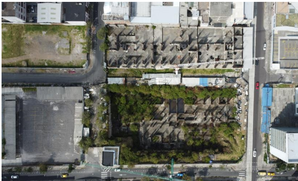
Figura 15 Vista área del lugar de intervención, lote IESS, Barrio Larrea, Quito, Ecuador
