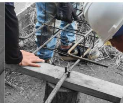
Doblado de varillas
