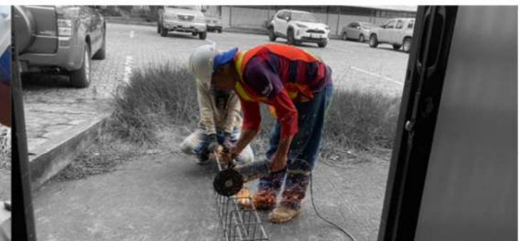
Armado de cimentación
