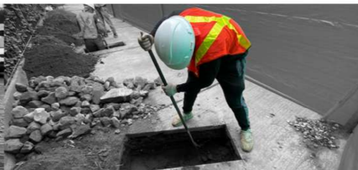
Se terminó de picar y excavar
