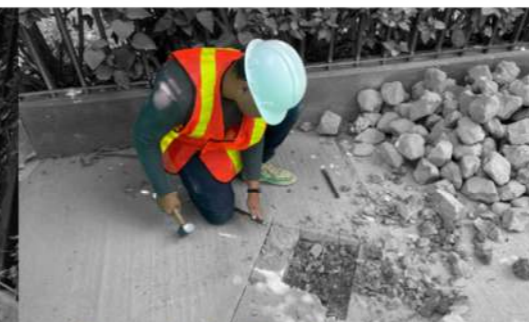
Rompimiento de acera
