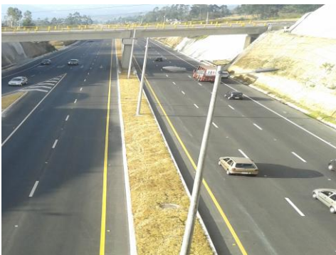
Fotografía 34. Postes de Luz colocados Sobre Parterre. Vía a Tababela
