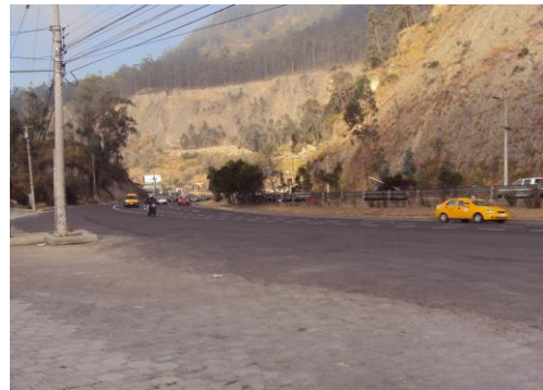
Fotografía 13. Pendiente Ascendente Av. Interoceánica
