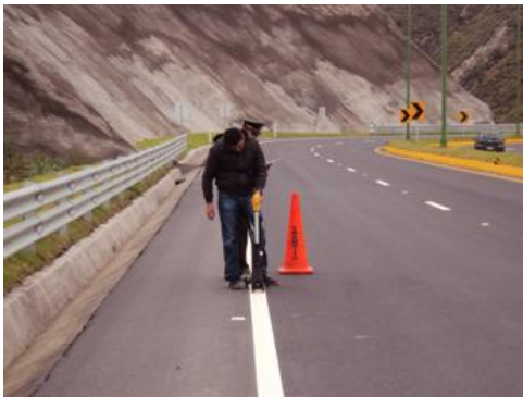
Fotografía 9. Retroreflectividad horizontal sobre pintura de pavimento color blanco
