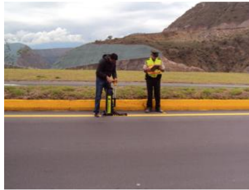
Fotografía 8. Retroreflectividad horizontal sobre pintura de pavimento color amarillo
