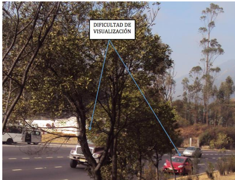
Fotografía 17. Curva vertical y Vegetación Impiden que los Conductores puedan Identificar a los Peatones en la Av. Interoceánica
