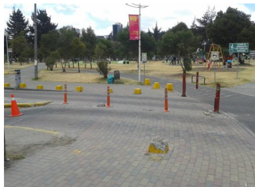
Fotografía 19. Delineadores de Carriles Parque La Carolina
