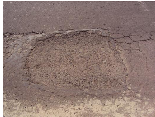
Fotografía 2. Parche colocado en Bache Sector Zámbriza
