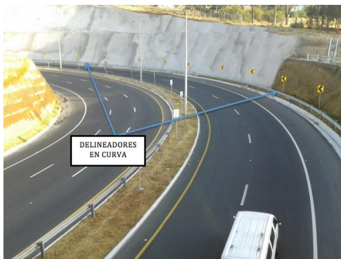
Fotografía 18. Delineadores de Curva Vía a Tababela
