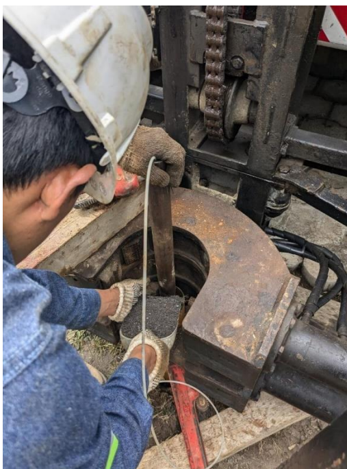
FOTOGRAFÍA 6. VERTIDO DE ARENA DE RELLENO DESDE LA SUPERFICIE (SEBASTIAN, 2025).
