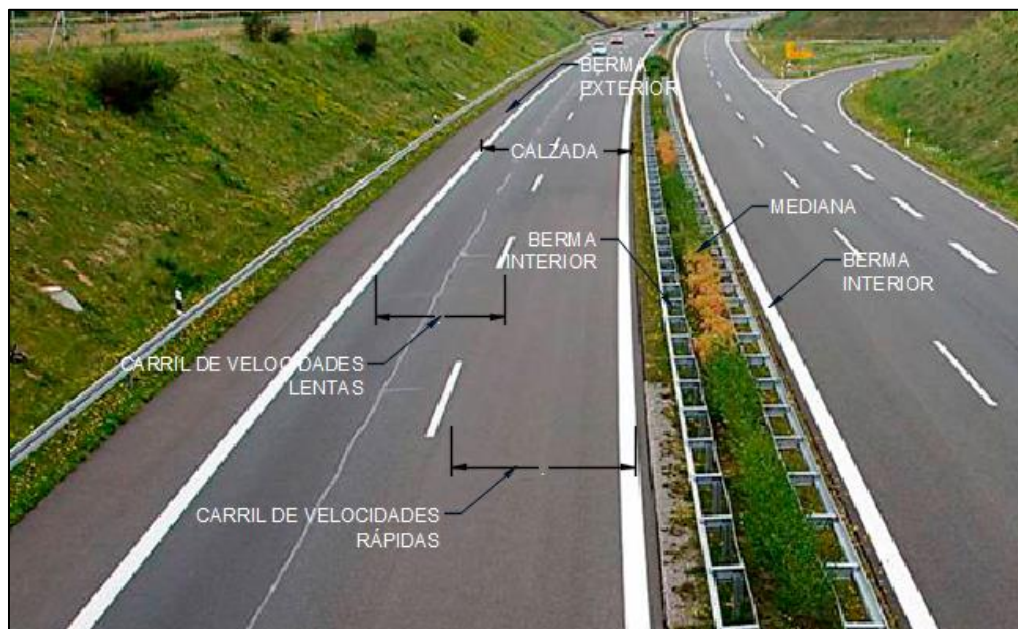
Ilustración 2: Elementos que integran una carretera - (NEVI -12-MTOP, 2013)
