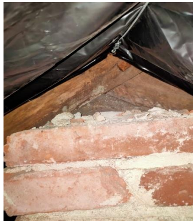
Figura 5. Unión media madera con perno no conforme a norma.
