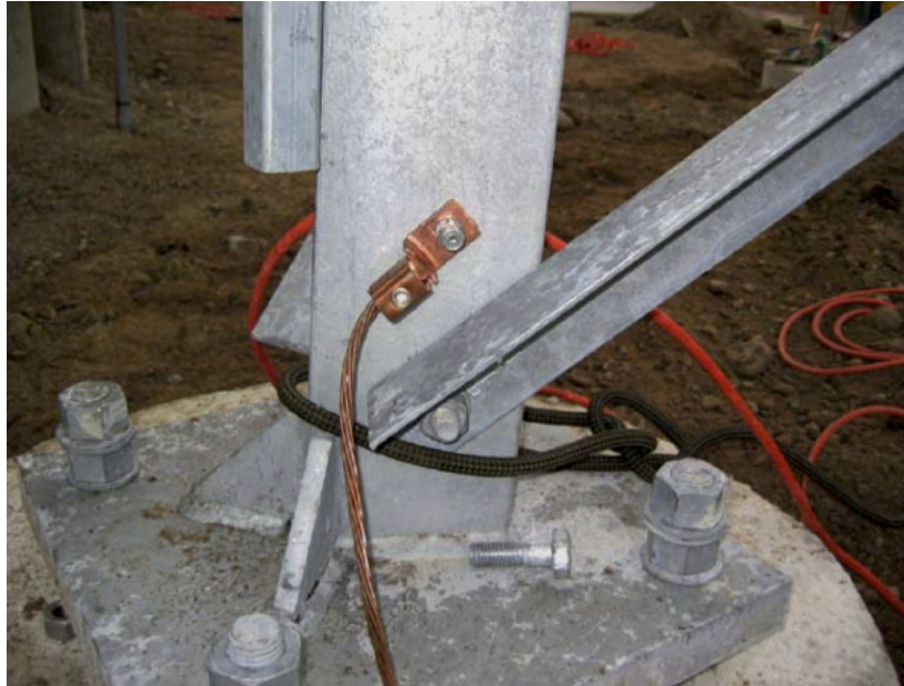
Figura 5.15 Aterrizaje a tierra de una torreta. (WNDW, 2013)
