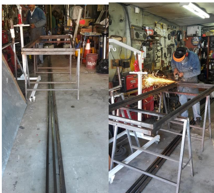
Fotografía 17: Corte y unión de piezas.
