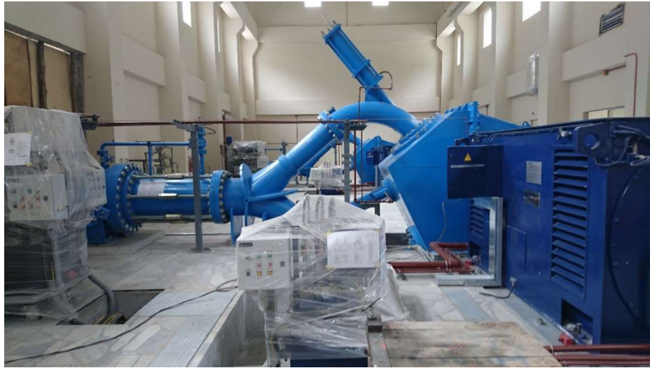
Fotografía 8.- Casa de máquinas.
