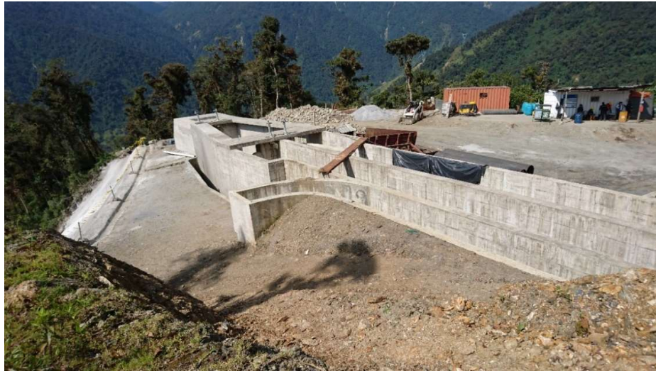
Fotografía 9.- Vista al desarenador Norte - Sur.
