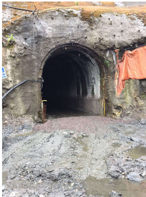
Fotografía 4.- Ingreso al túnel de conducción desde el desarenador.
