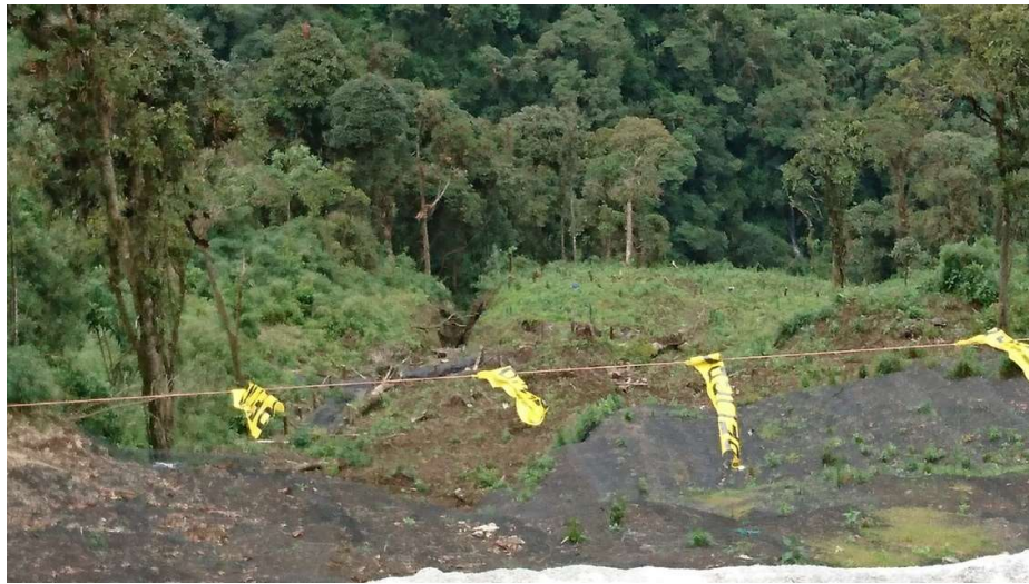
Fotografía 11.- Quebrada de descarga de la rápida de excesos.
