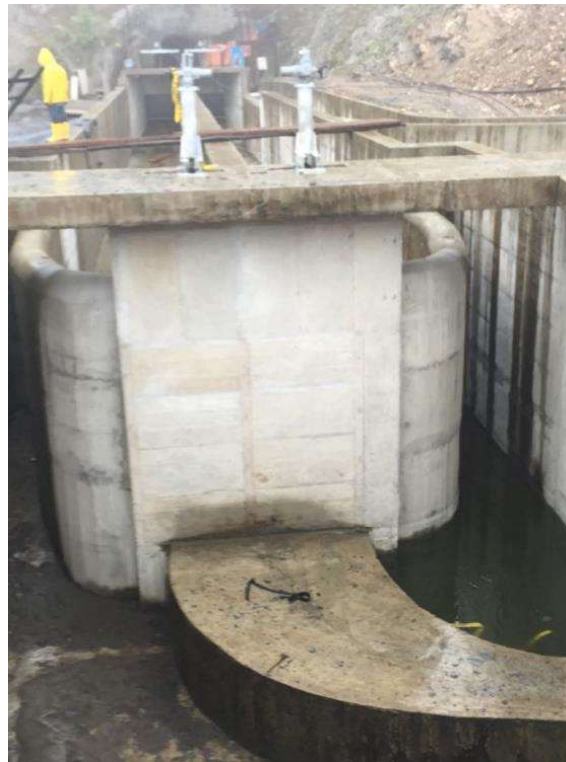
Fotografía 6.- Tanque de carga al final del desarenador.
