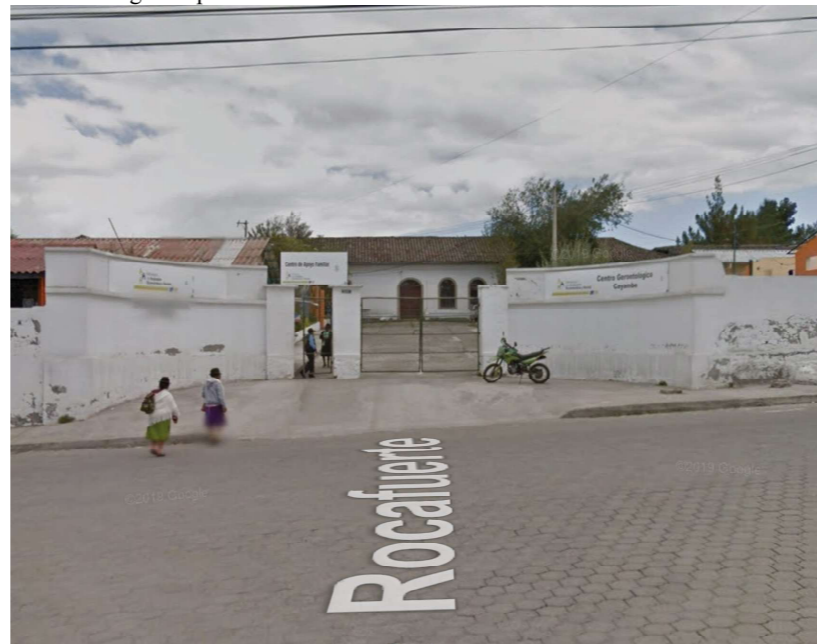
Figura N° 220. Remate "La Casona" Fuente: Google Maps.
