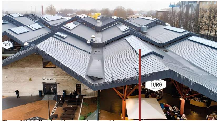
Figura N° 98. Iluminación natural en la cubierta. Fuente: Archdaily/Elaboración propia
