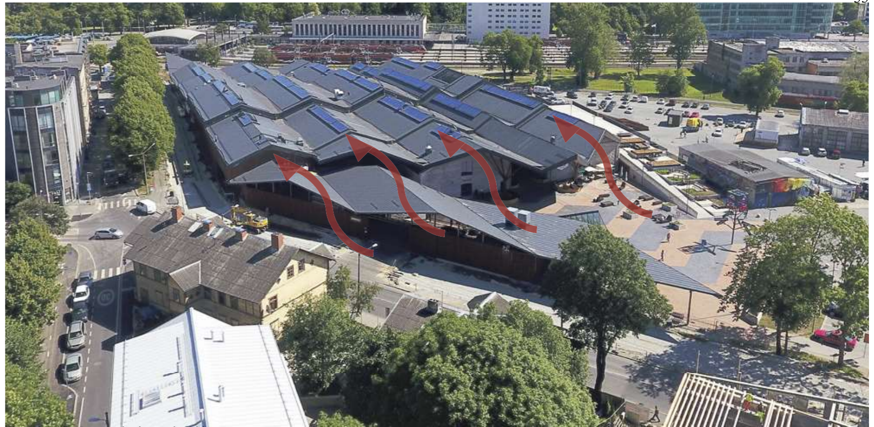
Figura N° 105. Ingreso de aire por la cubierta Fuente: EUmiesaward/Elaboración propia
