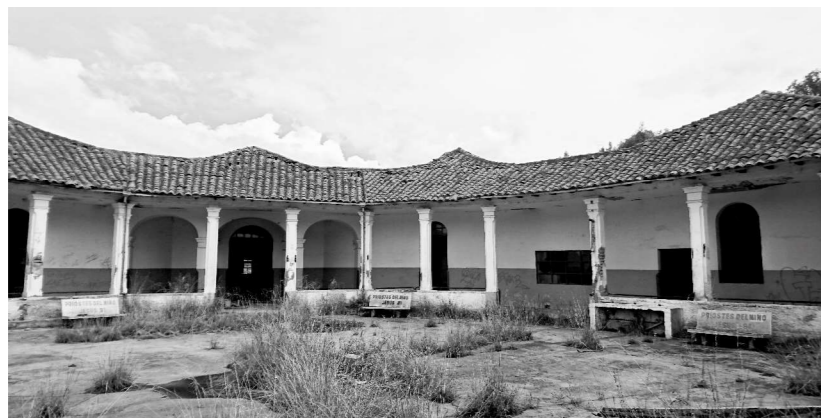
Figura N° 195. Iluminación natural patio central Fuente: Elaboración propia
