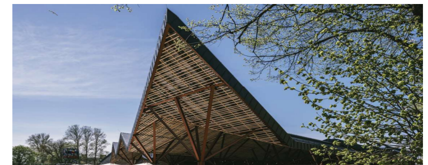
Figura N° 97. Cubierta. Fuente: Archdaily/Elaboración propia
