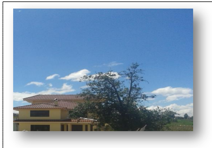
Imagen 5.5. Vista frontal de la Hostería SAN CRISTÓBAL
