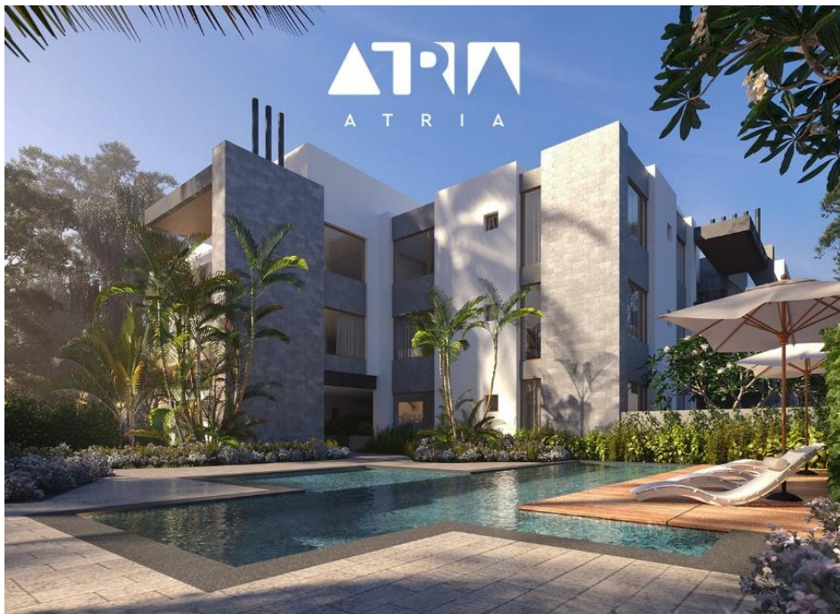
Figura 3.2. Edificio de vivienda Atria.
