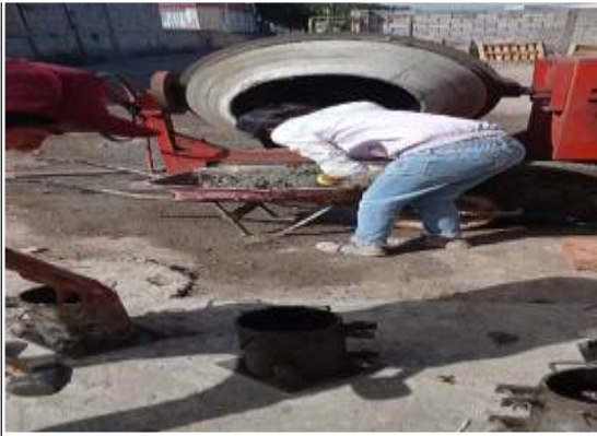
FUNDICIÓN DE CILINDROS DE HORMIGÓN
