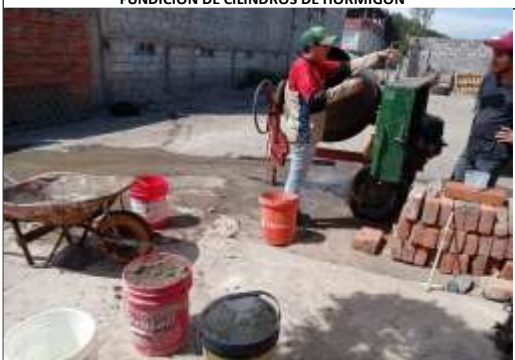
FUNDICIÓN DE CILINDROS DE HORMIGÓN
