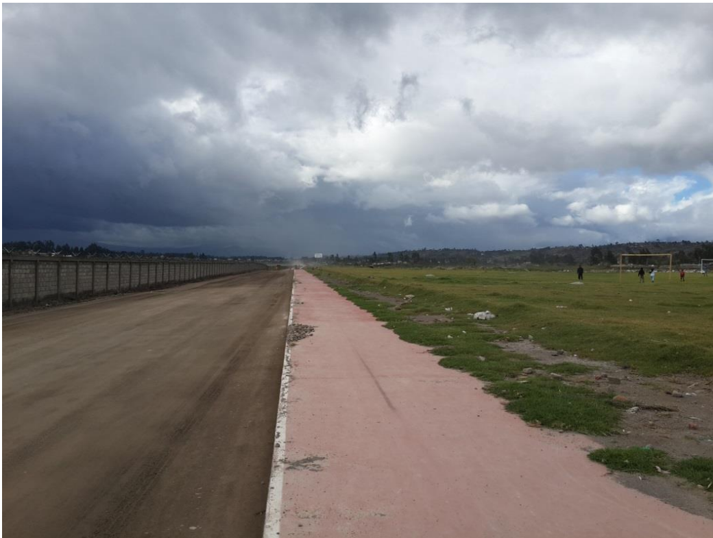
Figura 5. Ciclovia existente en la Ciudad de Latacunga Fuente: Archivo del Autor
