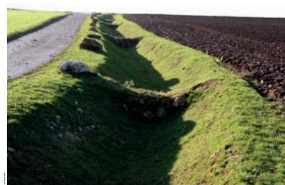
Ilustración 30 Zanjas con presas de contención
