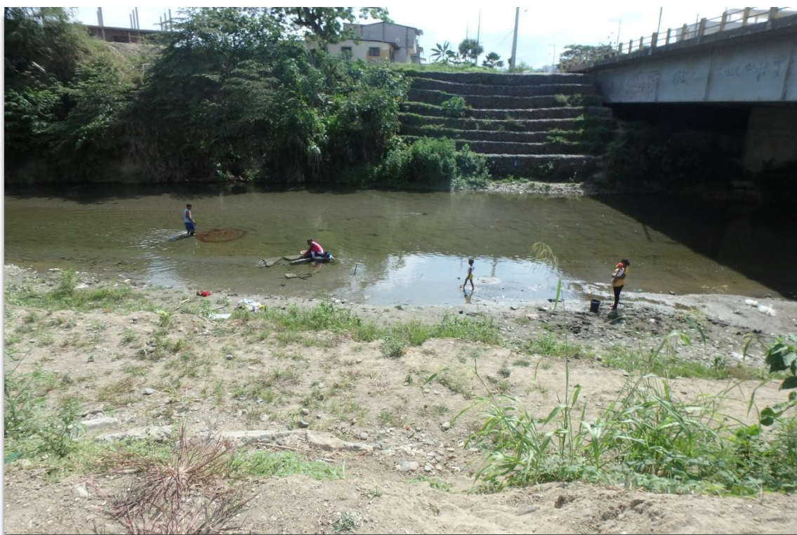
Zona baja: Puente del sector San Rafael
