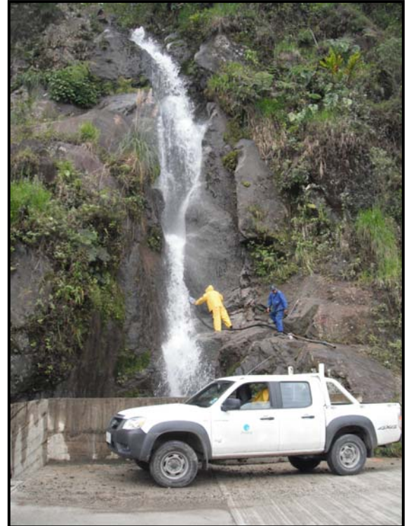
FOTO No. 2.- Abastecimiento de agua para perforación del sondeo LZ17-P1
