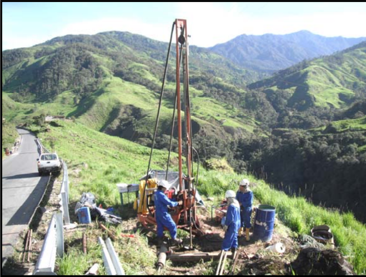
FOTO No. 1.- Localización del sondeo LZ17-P1, tramo abs. 17+950 – 18+450
