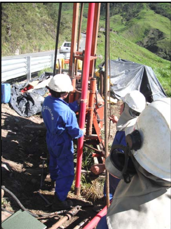
FOTO No. 3.- Colocación de tubería inclinométrica sondeo LZ17-P1
