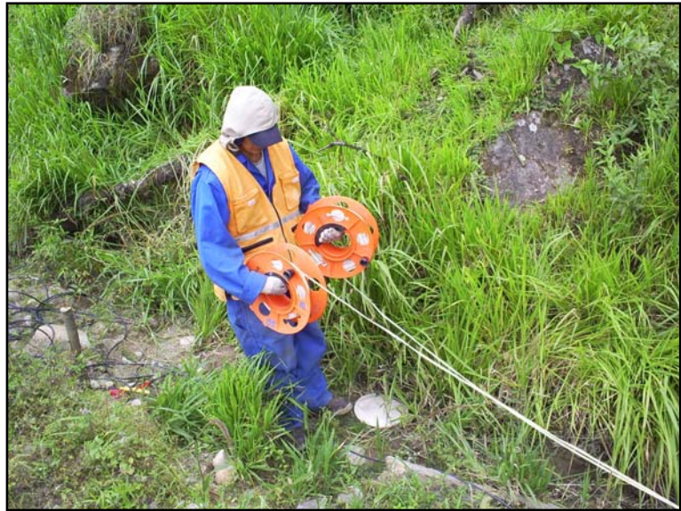
FOTO 1: Colocación de explosivos Línea para Sísmica de refracción Estabilidad de taludes Vía Loja- Zamora 17+950-18+450
