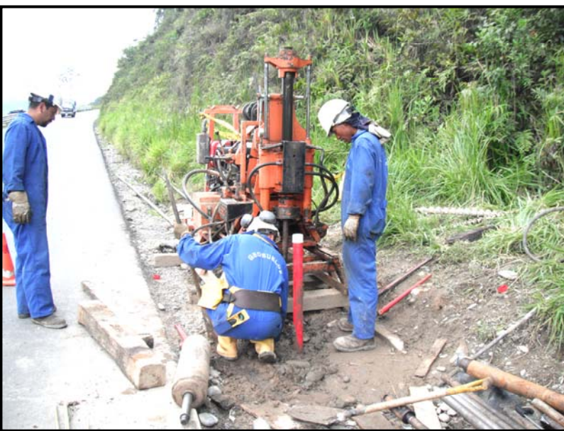
FOTO No. 3.- Instalación de tubería inclinométrica en el sondeo LZ17-P2
