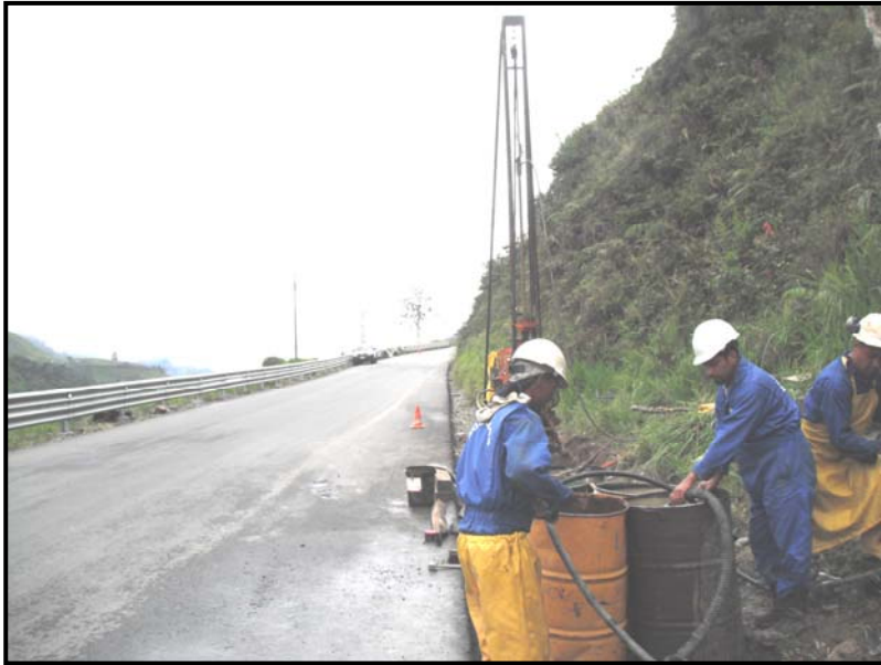
FOTO No. 1.- Localización del sondeo LZ17-P2, tramo abs. 17+950 – 18+450
