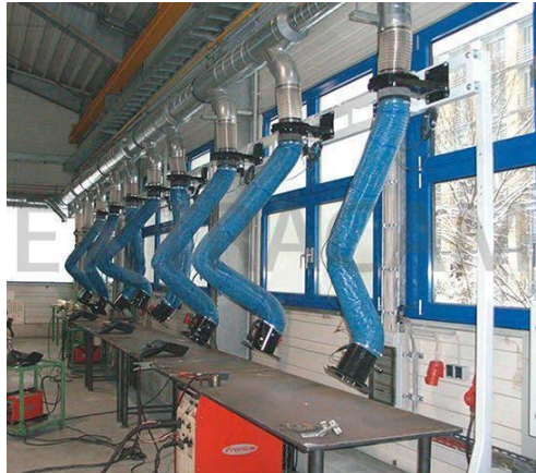
Figura 10. Ejemplo de sistema de extracción de humos
