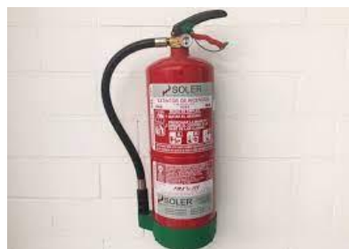
Figura 11. Ejemplo de extintor de incendios
