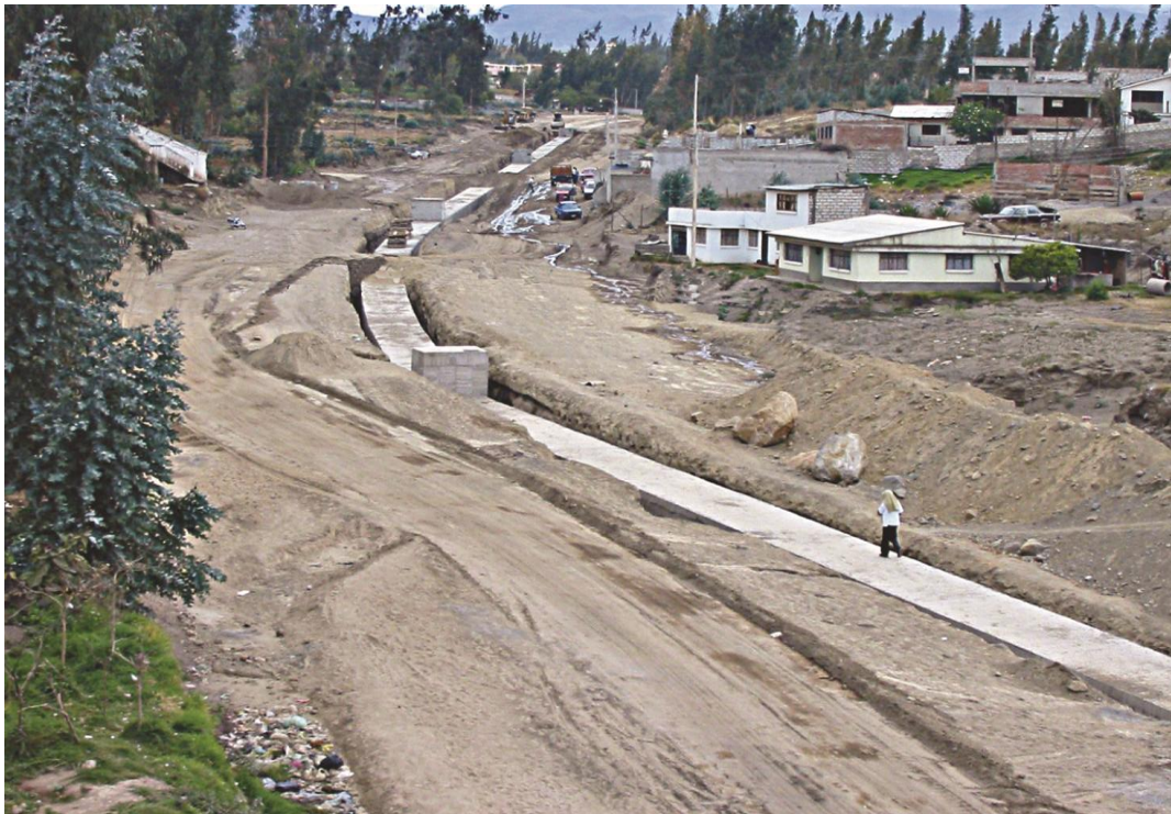
Figura 11: Obra pública terminada y en ejecución en el cantón Ambato
