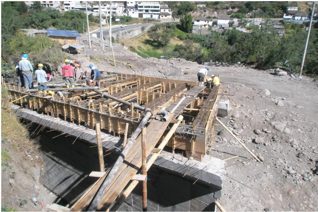
Figura 6: Construcción del puente de la calle Colombia
