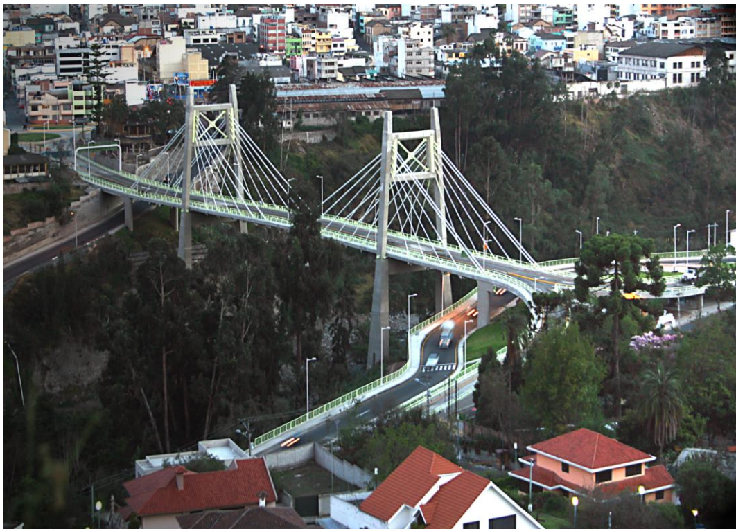
Figura 9: Construcción del puente Juan León Mera
