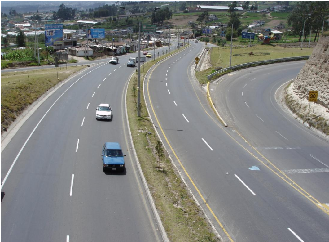
Figura 8: Pavimentación asfáltica del ingreso Norte
