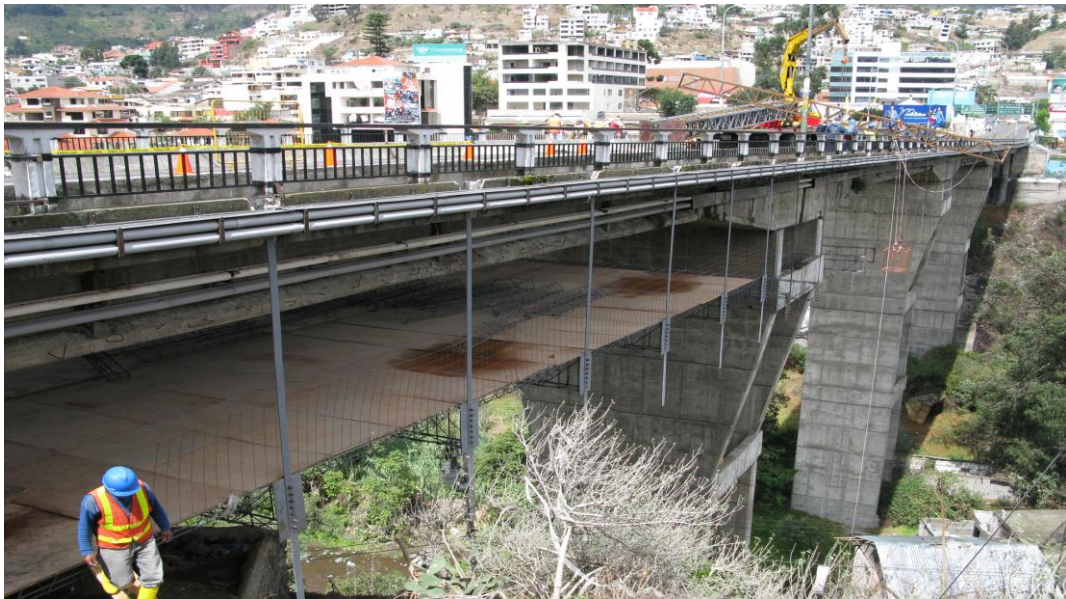
Figura 1: Mantenimiento del puente Martínez
