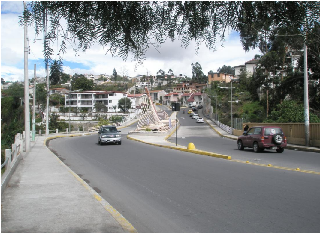
Figura 10: Construcción del puente Jaramillo de Ficoa
