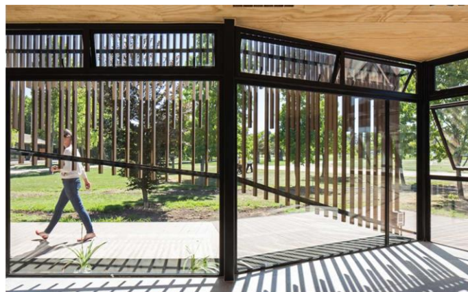
Fotografía 5: Sistema de celosías y aperturas en fachada del Centro de Arte y Cultura
