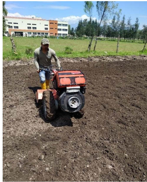
Anexo 32. Nivelación del suelo.
