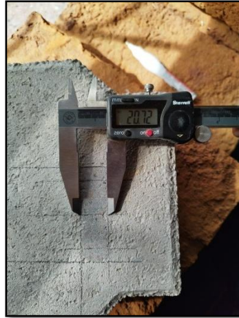
Ilustración 26 Medición de la huella de desgaste en el adoquín. Fuente: Autores.
