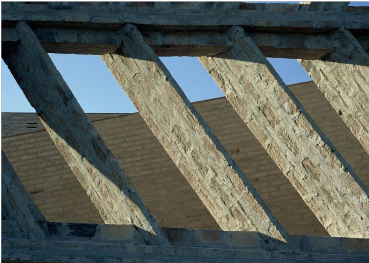
DETALLE DEL QUIEBRA VISTA DEL EDIFICIO UNILEVER FUENTE: SOLANO BENÍTEZ
